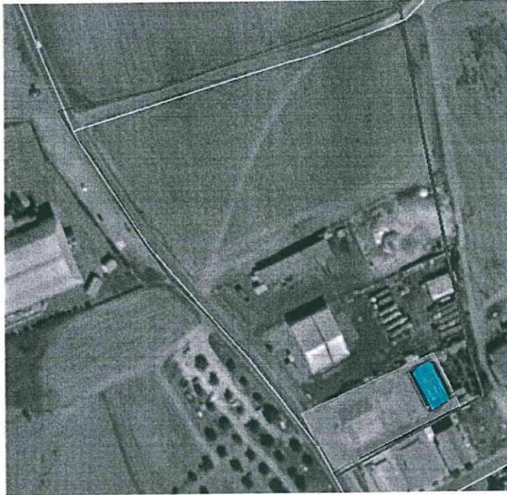
Περιοχή αποθήκευσης αποβλήτων (με κυανό χρώμα)
