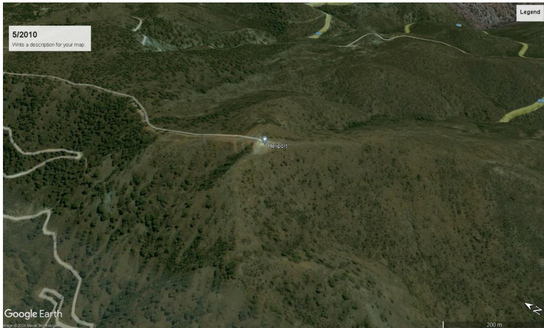
Εικόνα 5: 5/2010 : Ευρεία περιοχή ενδιαφέροντος πριν την εκτέλεση των επεμβάσεων.
