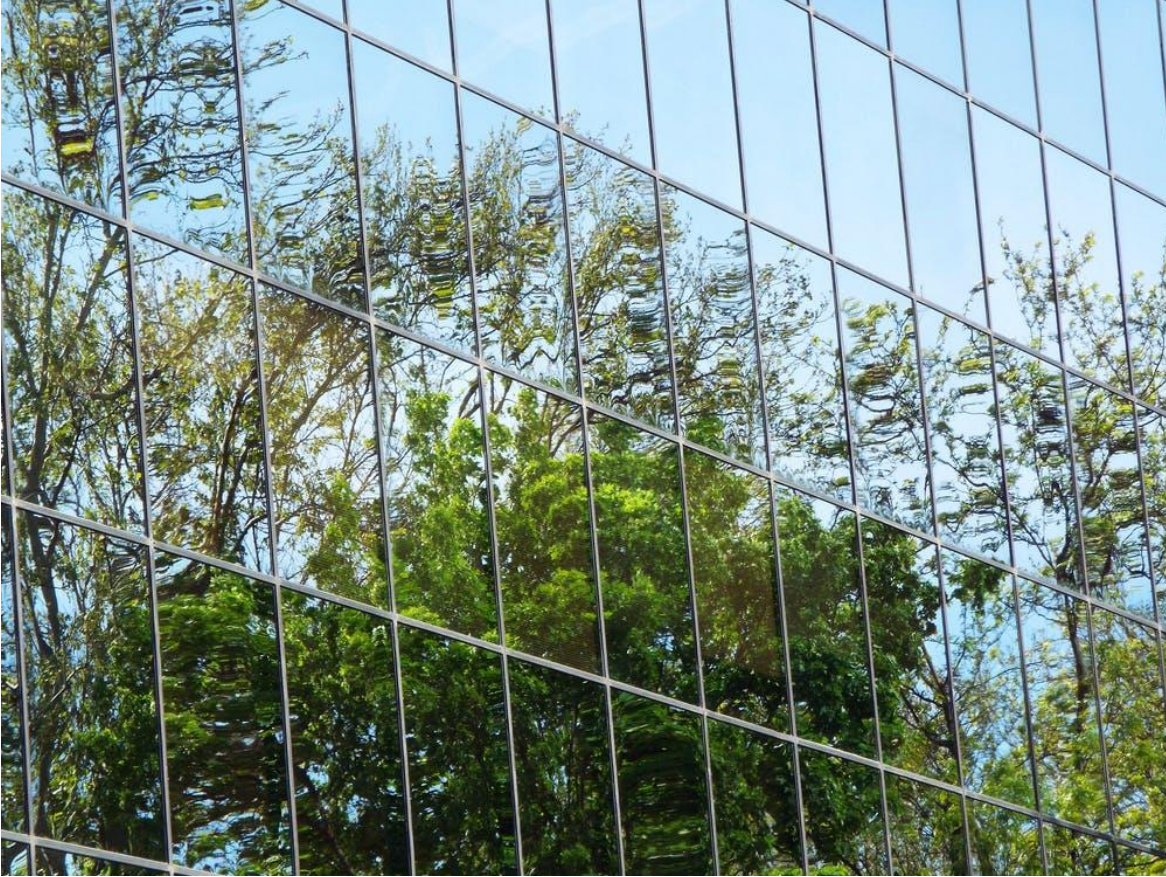
Εικόνα 7-2: Παράδειγμα αντανακλώμενης επιφάνειας υψηλού κτιρίου που μπορεί να αποτελέσει αιτία αποπροσανατολισμού και πρόσκρουσης των πτηνών
