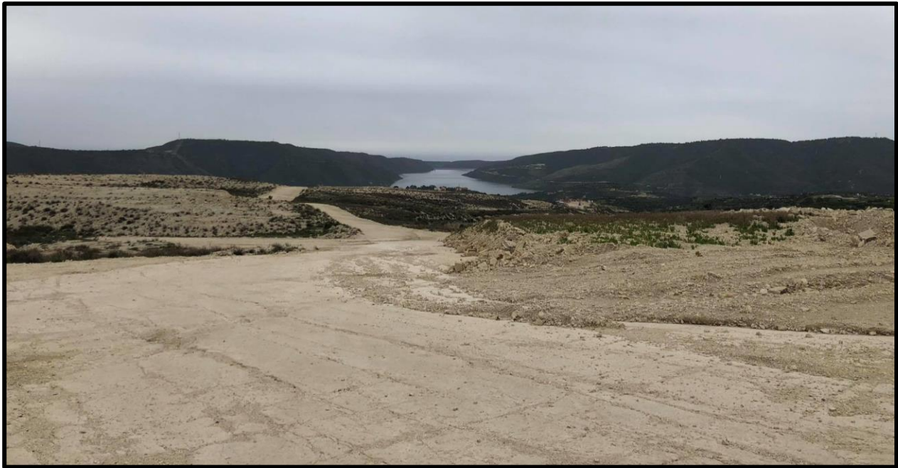
Φωτογραφία 3-3: Φράγμα του ποταμού Κούρρη νοτιοδυτικά της ΑΠΜ
