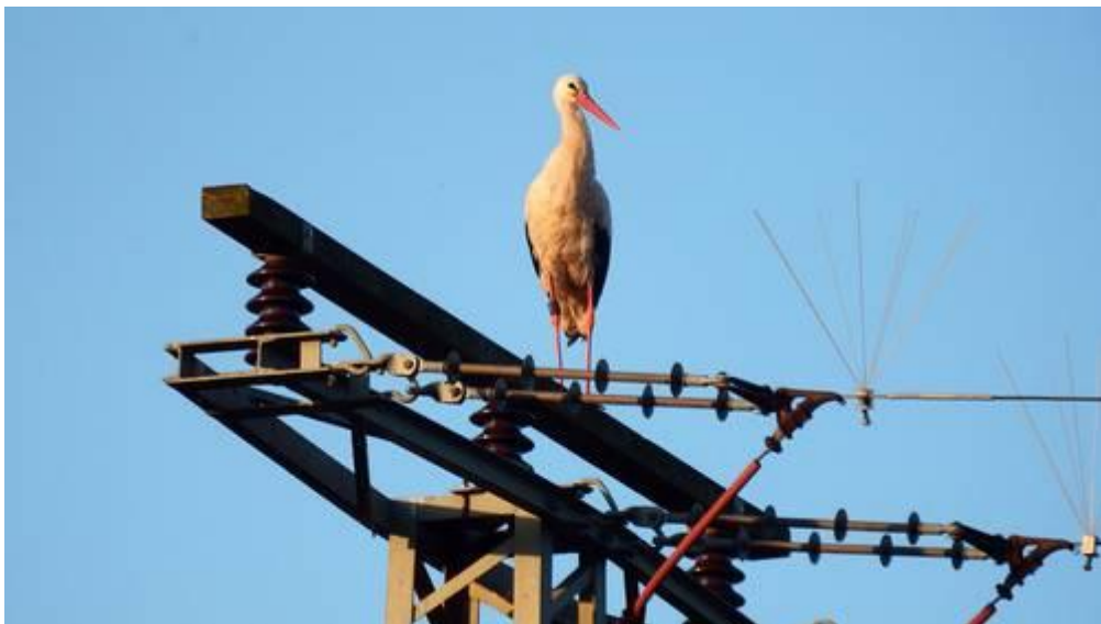
Εικόνα 7-2: Εφαρμογή μέτρου μείωσης του κινδύνου θνησιμότητας των πτηνών από προσκρούσεις στα καλώδια μεταφοράς ρεύματος
