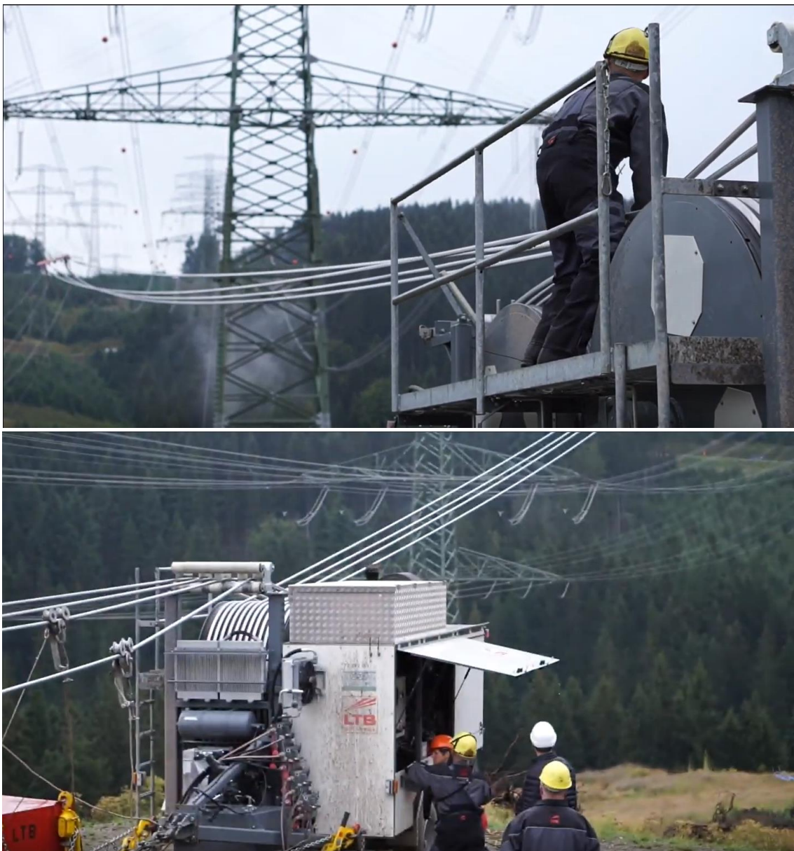
Εικόνα 3-4: Εγκατάσταση αγωγών στους πυλώνες με το μηχάνημα pull/tensioner
