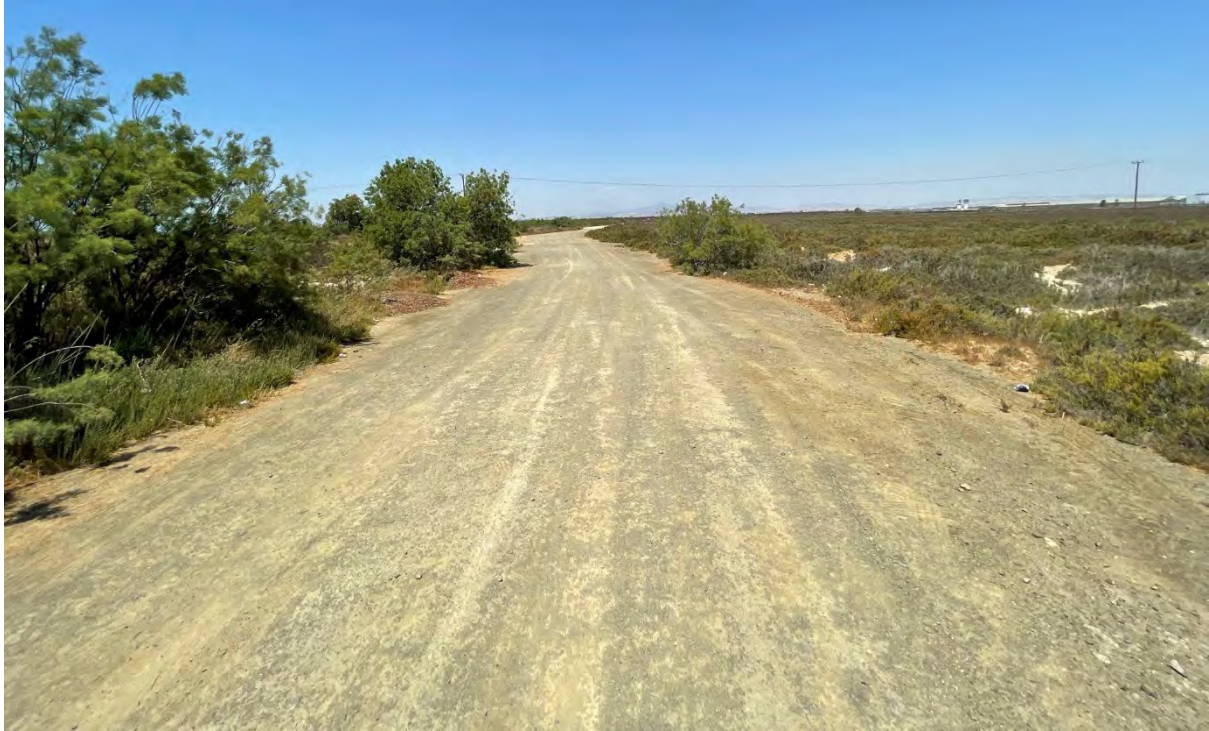
Φωτογραφία 7: Το υφιστάμενο οδικό δίκτυο οδού του αγωγού πίεσης (εναλλακτική 3) .
