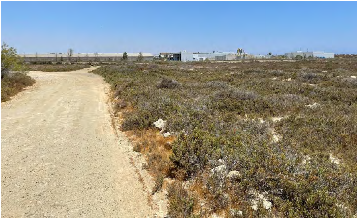
Φωτογραφία 7: Το υφιστάμενο οδικό δίκτυο οδού του αγωγού πίεσης (εναλλακτική 3) και στο βάθος η ΕΕΛ για τη διαχείριση των λυμάτων.
