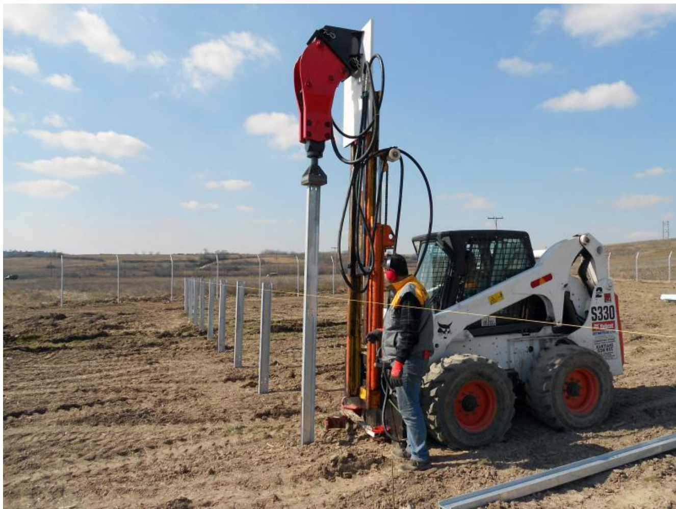
Εικόνα 3-5: Παράδειγμα μηχανήματος πασσαλόμπτυξης μεταλλικών βάσεων Φ/Β Συστήματος [Πηγή: edrasol.gr]
