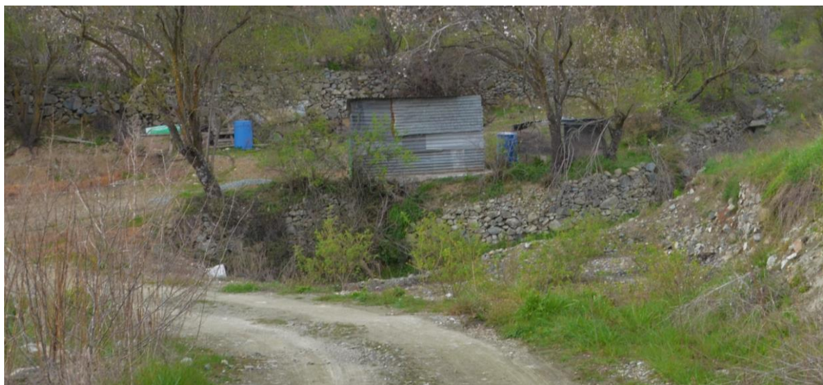
Εικόνα 11: Υδατόρεμα το οποίο διασχίζεται από το υφιστάμενο χωμάτινο οδικό δίκτυο
