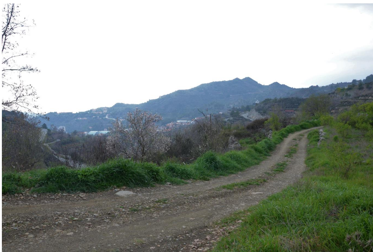
Εικόνα 5: Υφιστάμενος χωμάτινος μη-εγγεγραμμένος δρόμος
