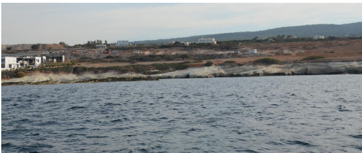
Σχήμα 5-1. Άποψη της περιοχής μελέτης από τη θάλασσα (η θέση λήψης της φωτογραφίας φαίνεται στο ακόλουθο σχήμα, με πορτοκαλί χρώμα)
