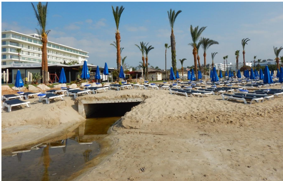
Εικόνα 5-2: Εκβολή υπογειοποιημένου υδατορέματος στην παραλία
