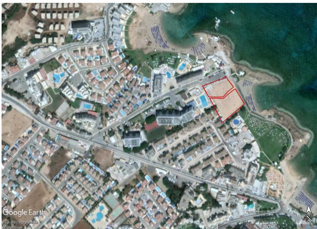
Εικόνα 1: Δορυφορική Εικόνα της ευρύτερης περιοχής. Το τεμάχιο όπου θα χωροθετηθεί η προτεινόμενη ανάπτυξη σημειώνεται με κόκκινο περίγραμμα.
