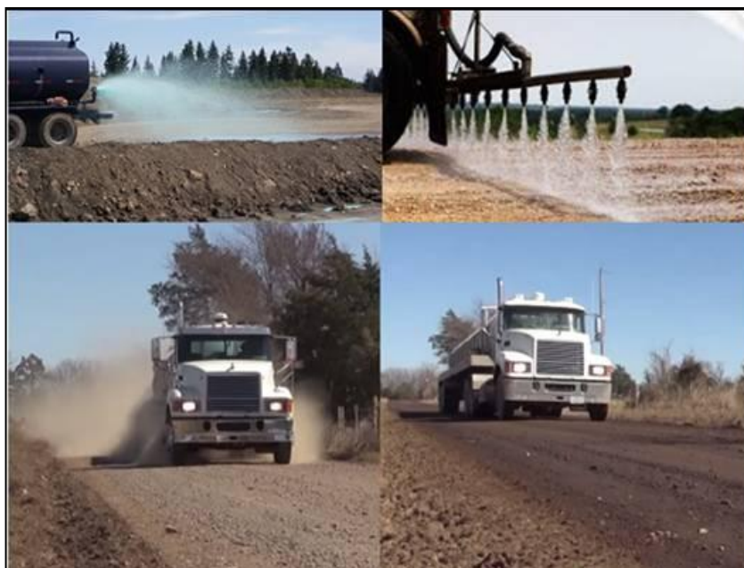
Εικόνα 2: Μέθοδος διαβροχής χωμάτινων οδών για τον περιορισμό εκπομπής σκόνης
