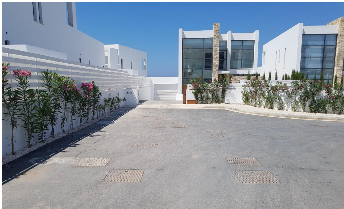
Εικόνα 5. Παράδειγμα τελικής διαμόρφωσης του βιολογικού σταθμού. Διακρίνονται μόνο οι ανθρωποθυρίδες πάνω στο δρόμο.
