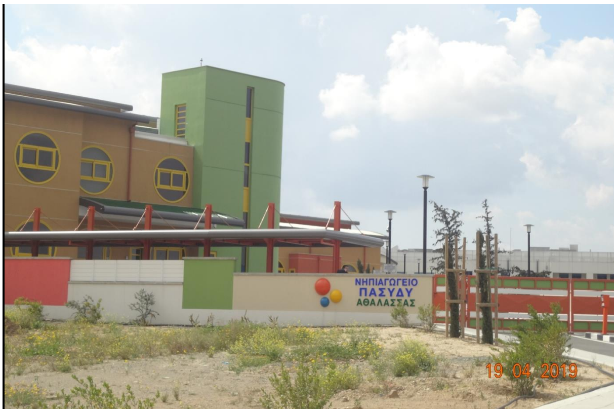
Φωτογραφία 6: Νηπιαγωγείο στα νοτιοανατολικά της προτεινόμενης ανάπτυξης
