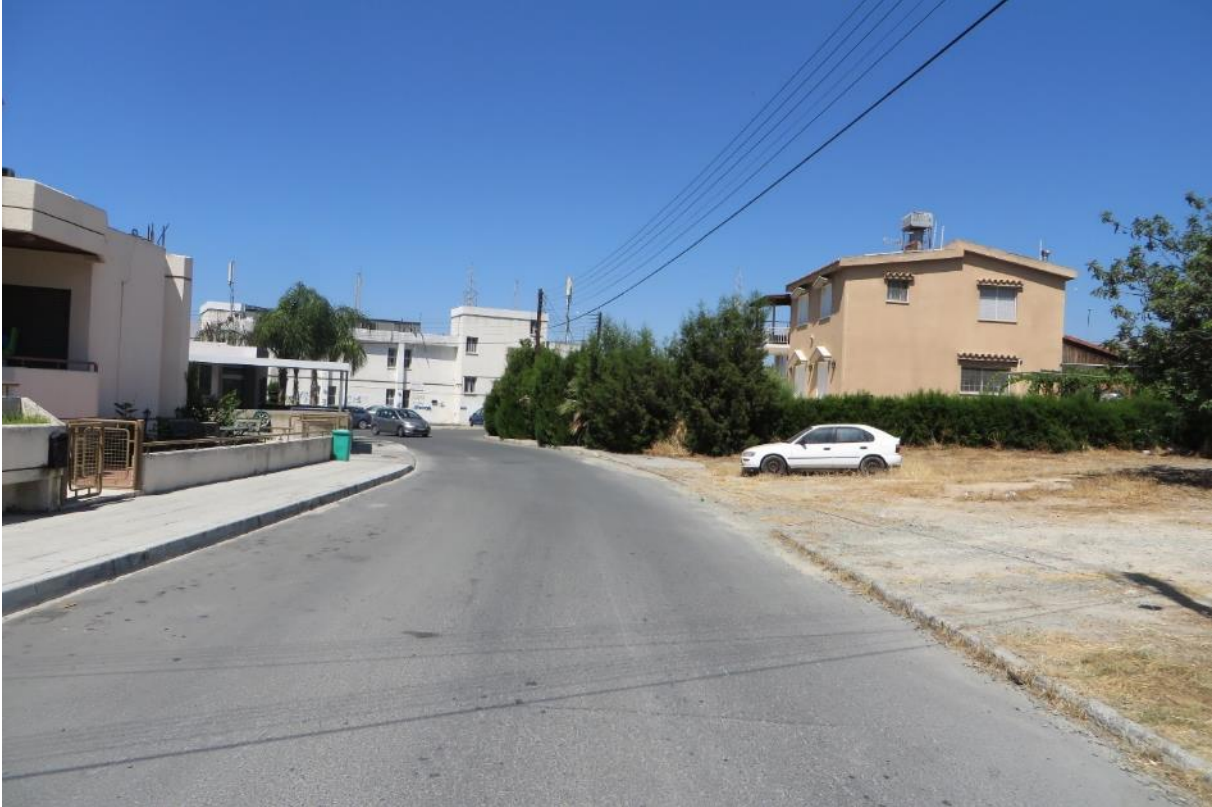
Φωτογραφία 15: Οδός Γάγγη, στο βάθος διακρίνεται η υφιστάμενη υπεραγορά που θα κατεδαφιστεί, όπως και το σπίτι στα δεξιά, το οποίο εμπίπτει στο τεμάχιο ανάπτυξης με αριθμό 934
