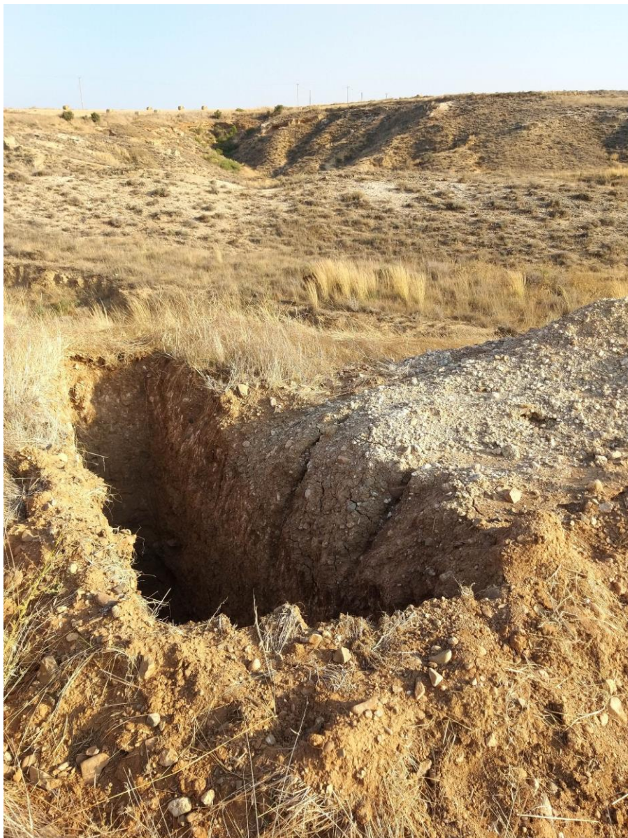
Εκσκαφή 1. Στο νοτιότερο χαμηλό σημείο του τεμαχίου 636.
