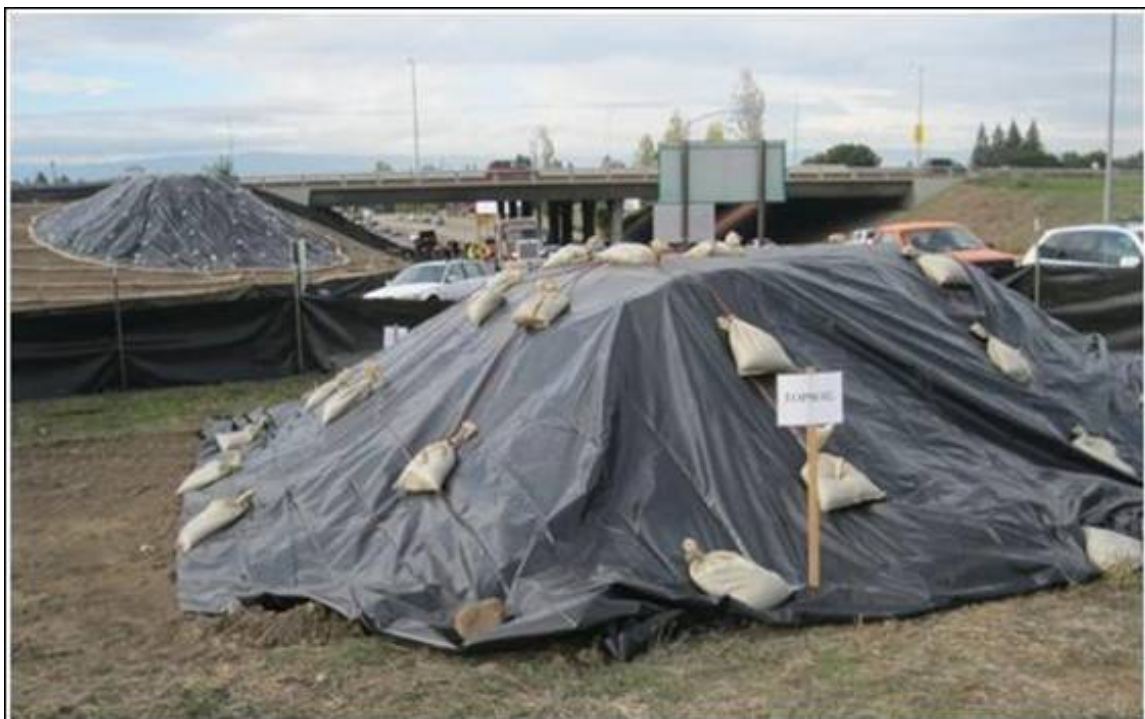
Εικόνα 6: Πλαστική Μονωτική Μεμβράνη κάλυψης αδρανών υλικών/μπαζών εργοταξίου
