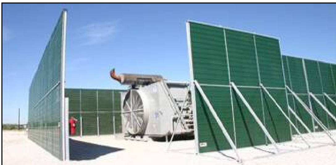
Εικόνα 4: Χρήση ηχοπετασμάτων σε σταθερές πηγές θορύβου
