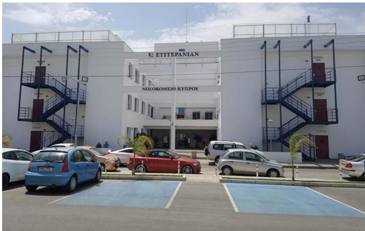
Φωτογραφία 1: Το κτήριο του υφιστάμενου κτηρίου του έργου
