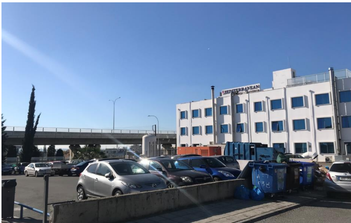
Φωτογραφία 3: Πλάγια όψη υφιστάμενου κτηρίου του έργου όπου φαίνονται και κάποιοι από τους χώρους στάθμευσης
