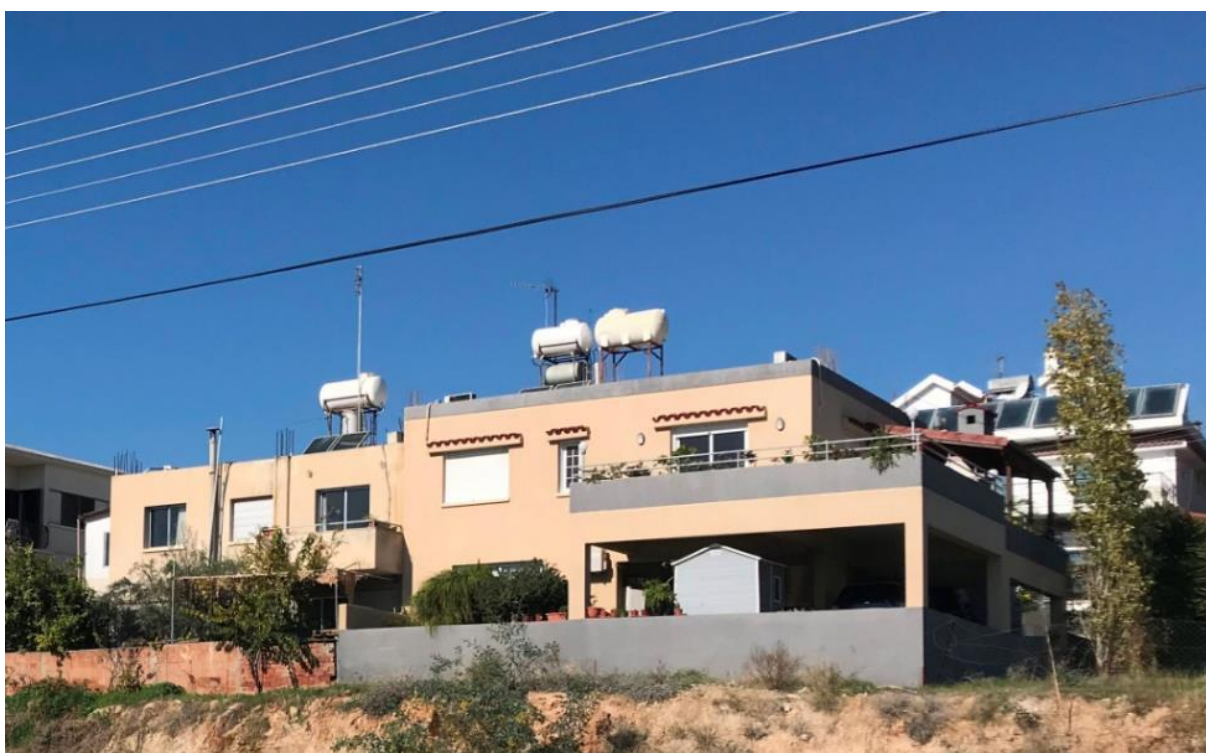
Φωτογραφία 6: Οικιστικές αναπτύξεις βόρεια του υφιστάμενου νοσοκομείου
