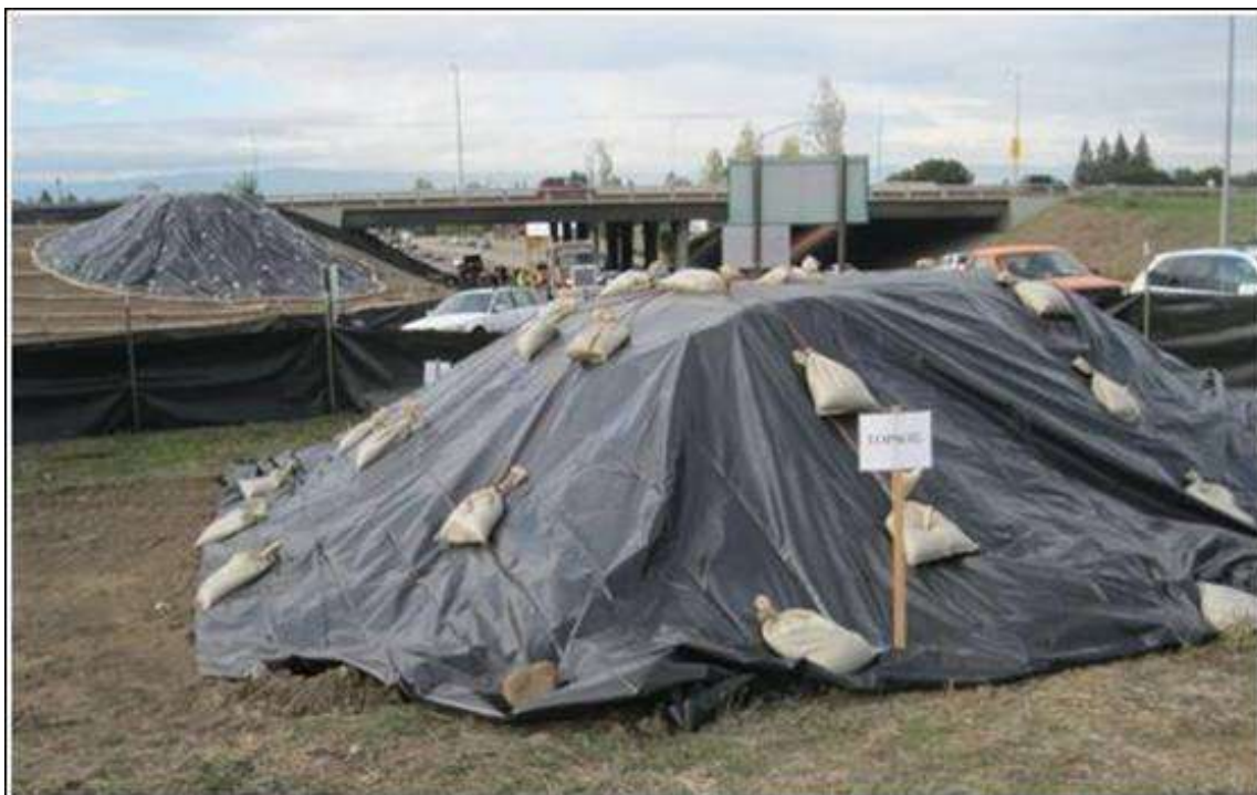
Εικόνα 6: Πλαστική Μονωτική Μεμβράνη κάλυψης αδρανών υλικών/μπαζών εργοταξίου
