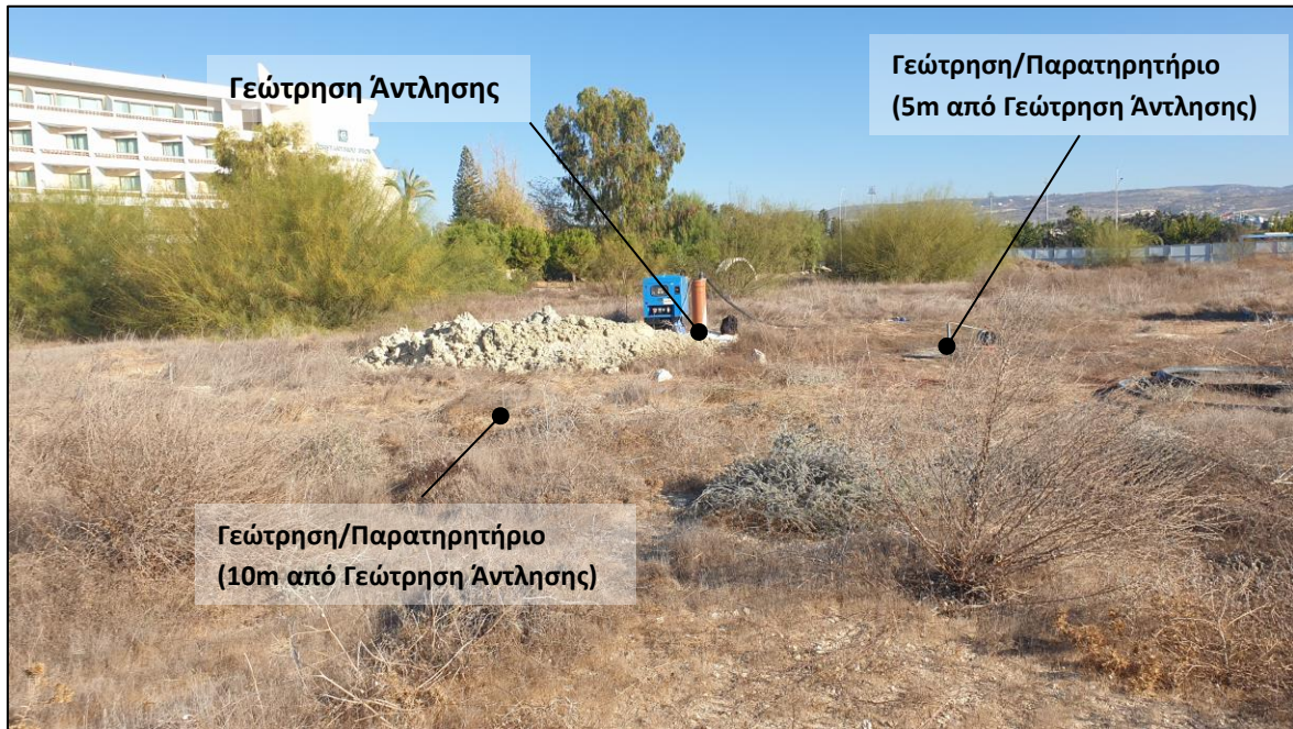
Φωτογραφία 2: Εργασίες δοκιμαστικής άντλησης (κατεύθυνση φωτογραφίας: προς βόρεια)
