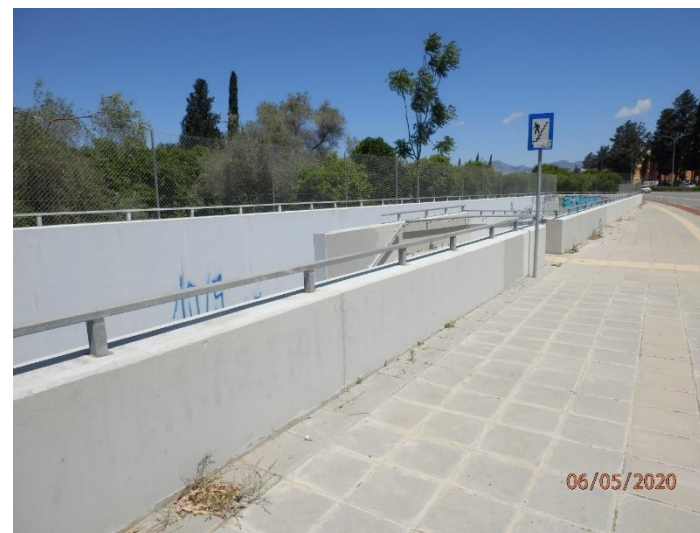
Φωτογραφία 8: Υπόγεια διάβαση που εφάπτεται με το τεμάχιο ανάπτυξης (ανατολικά).
