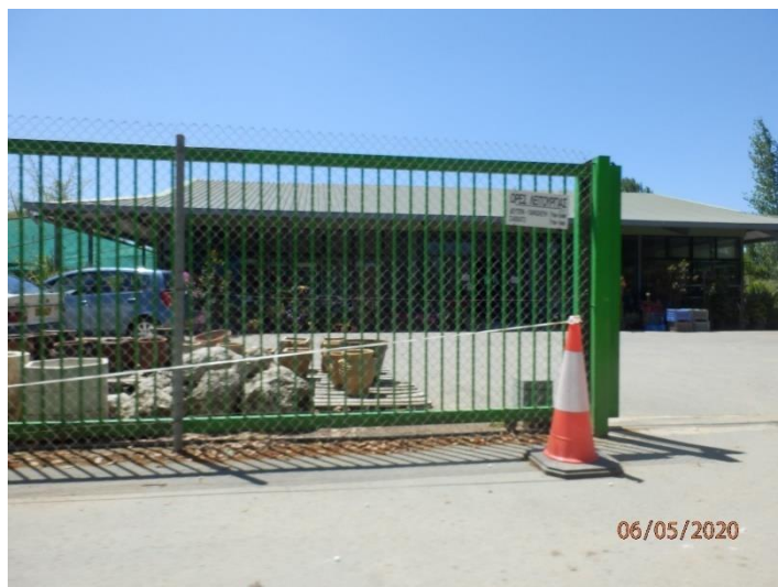
Φωτογραφία 7: Εγκαταστάσεις υφιστάμενου καταστήματος φυτωρίου.
