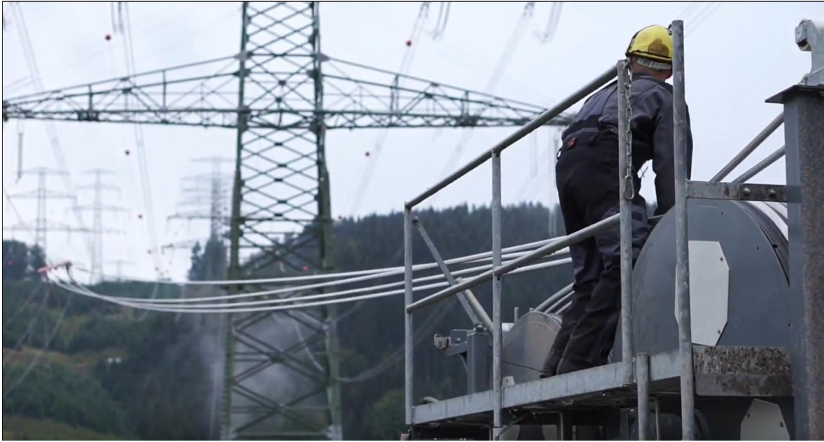
Εικόνα 4: Εγκατάσταση αγωγών στους πυλώνες με το μηχάνημα pull/tensioner
