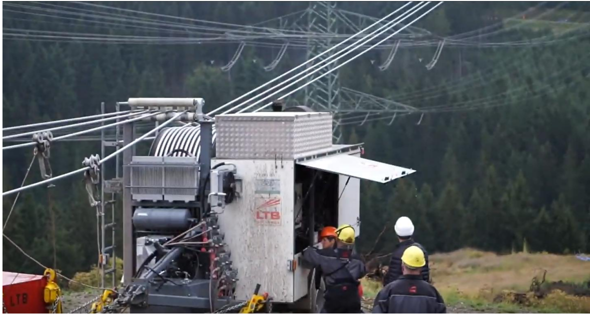
Εικόνα 6: Εγκατάσταση αγωγών στους πυλώνες με το μηχάνημα pull/tensioner
