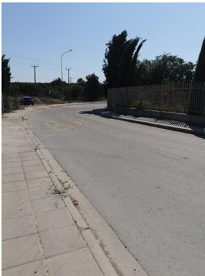
Φωτογραφία 4: Δρόμος Πρόσβασης νότια από τον Υποσταθμό
