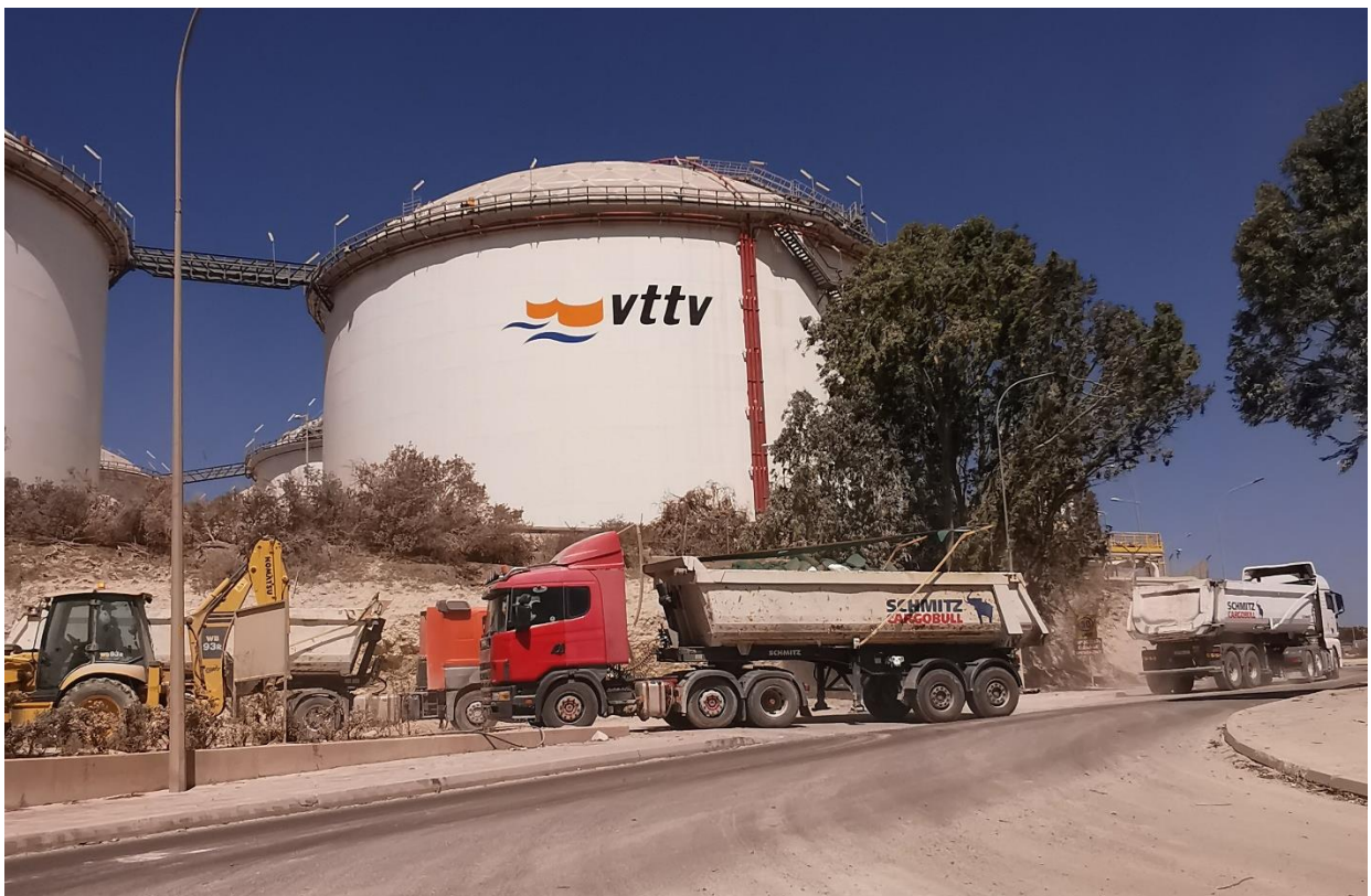
Φωτογραφία 2: Τερματικός σταθμός καυσίμων της VTTV – Διακίνηση βαρέων οχημάτων στην ΕΠΜ
