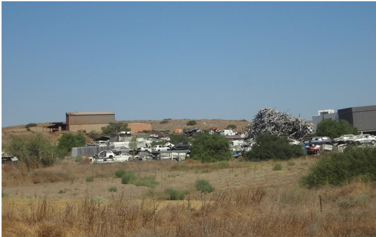
Φωτογραφία 10: Ανοιχτός χώρος απόθεσης υλικών δυτικά των τεμαχίων του προτεινόμενου Έργου
