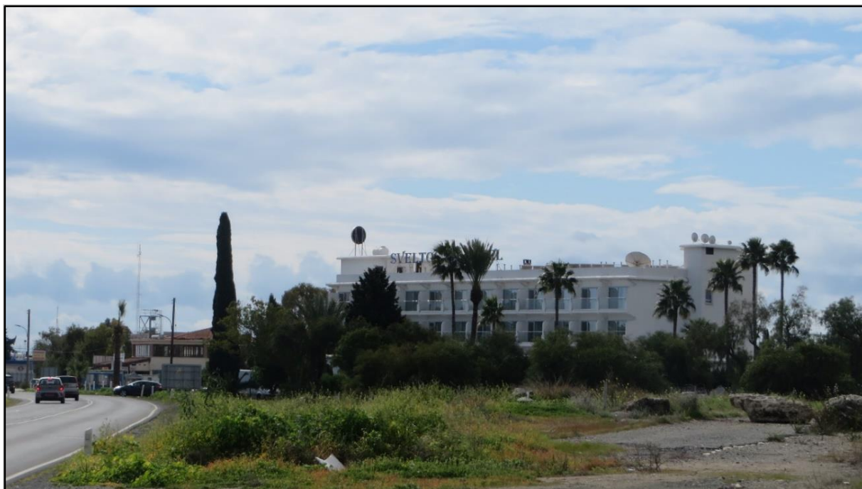
Φωτογραφία 1: Το υφιστάμενο κτήριο του Έργου (όψη από τα βόρεια προς τα νότια).
