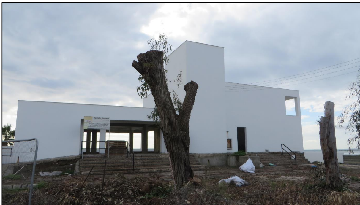
Φωτογραφία 17: Υπό κατασκευή κτήριο το οποίο βρίσκεται περίπου στα 300 μέτρα νότια του χώρου όπου χωροθετείται το Έργο.
