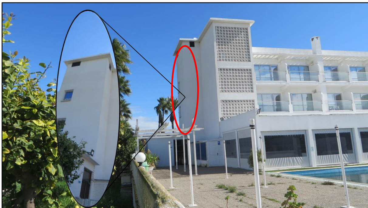
Φωτογραφία 5: Ο τοίχος (κόκκινο περίγραμμα) της υφιστάμενης ανάπτυξης που θα κατεδαφιστεί για τη δημιουργία γεφυρωμάτων με το νέο κτήριο.
