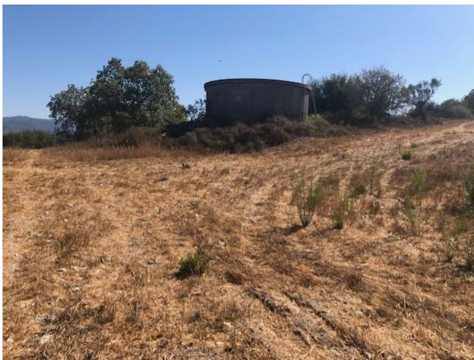
Εικόνα 1: Χώρος Ανάπτυξης - Ντεπόζιτο Νερού
