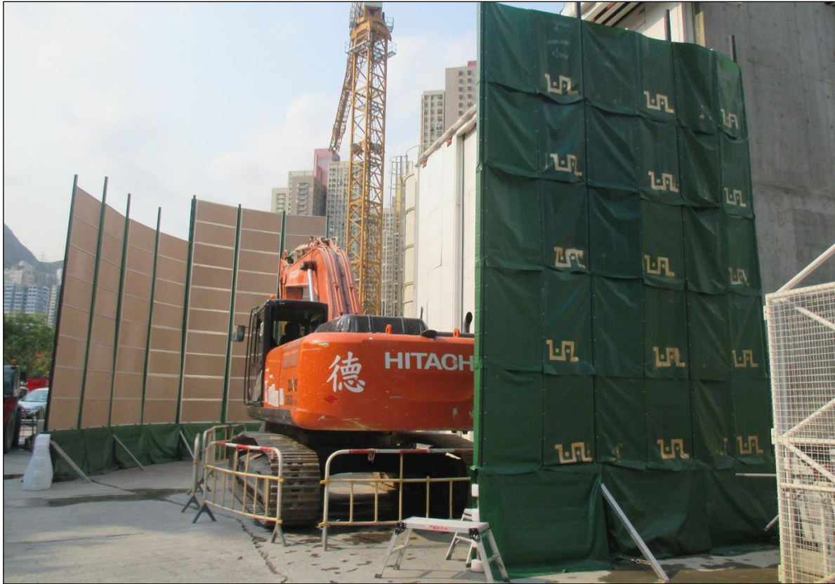
Εικόνα 11: Χρήση ακουστικών ηχοπετασμάτων γύρω από την περιοχή όπου προκαλούνται υψηλά επίπεδα θορύβου
