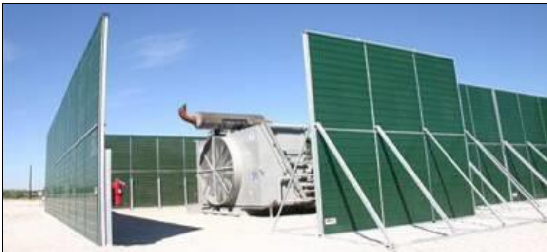
Εικόνα 10: Χρήση ηχοπετασμάτων σε σταθερές πηγές θορύβου
