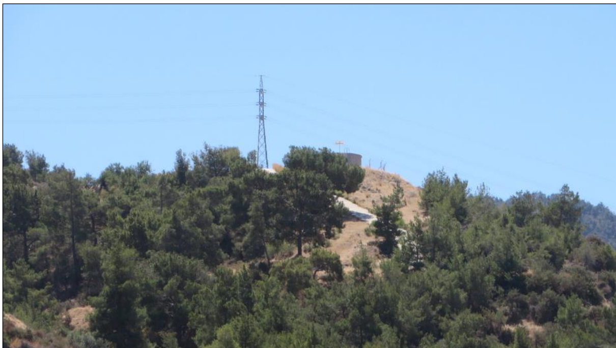
Φωτογραφία 15: Υπέργειες ηλεκτρικές γραμμές και ντεπόζιτο νερού, προς τα νότια του υπό μελέτη τεμαχίου.
