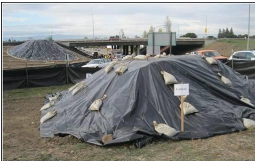
Εικόνα 19: Παράδειγμα κάλυψης μπαζών/αδρανών στο εργοτάξιο
