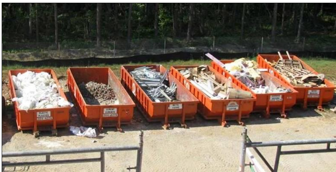
Εικόνα 20: Παράδειγμα συλλογής και διαχωρισμού αποβλήτων στο εργοτάξιο
