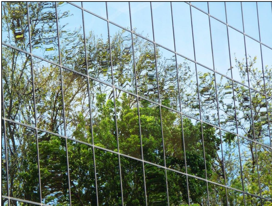
Εικόνα 13: Παράδειγμα αντανακλώμενης επιφάνειας υψηλού κτιρίου που μπορεί να αποτελέσει αιτία αποπροσανατολισμού και πρόσκρουσης των πτηνών
