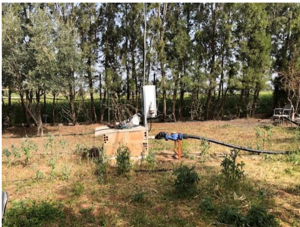
Φωτογραφία 24: Υφιστάμενη γεώτρηση στο τεμάχιο του Προτεινόμενου Έργου
