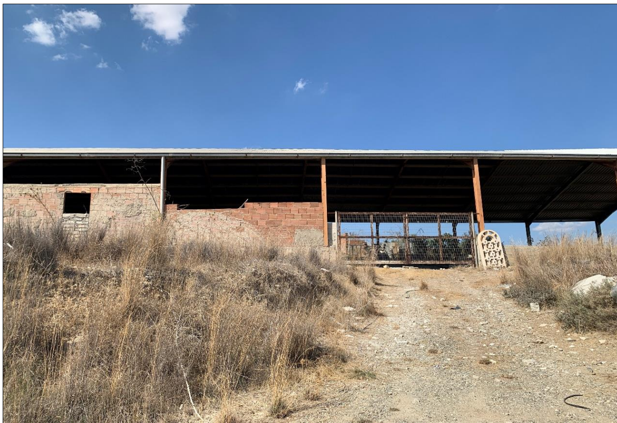
Φωτογραφία 10: Εγκαταλελειμμένο κτήριο.
