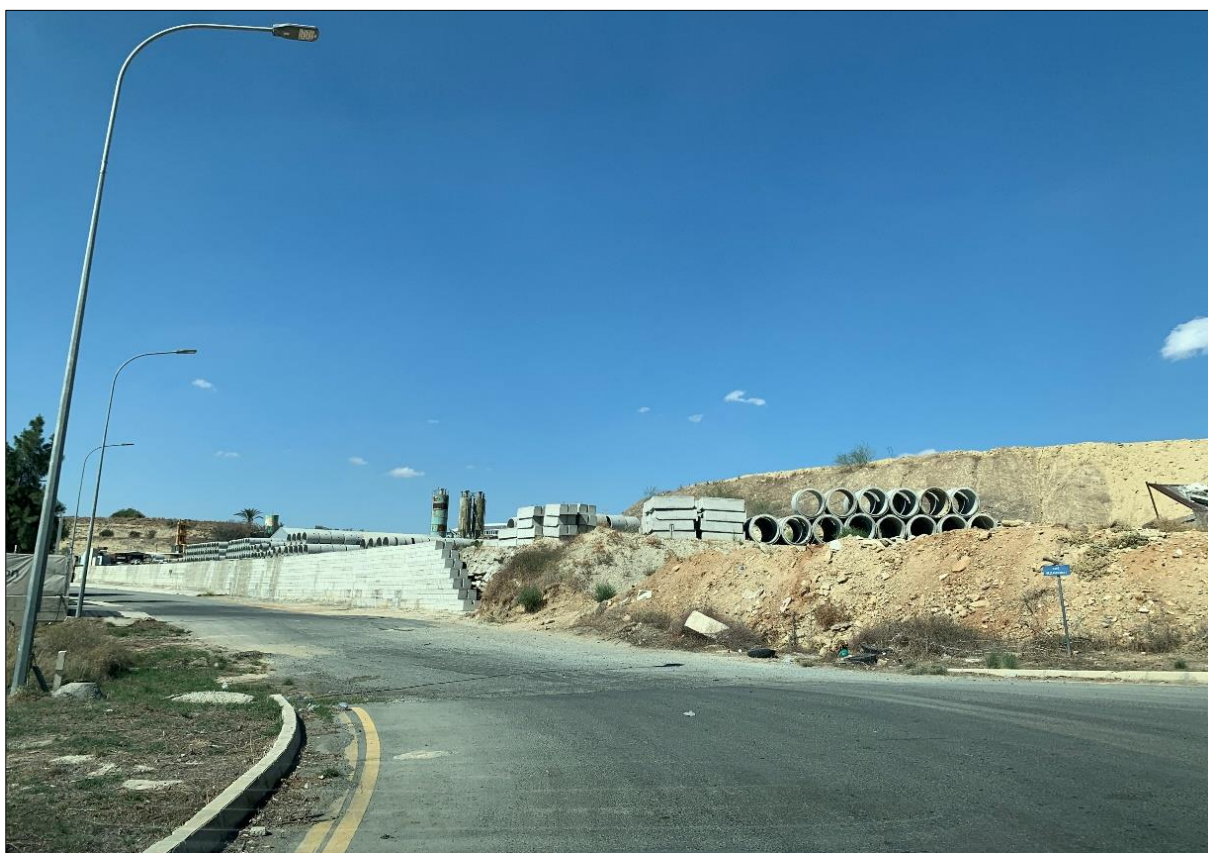
Φωτογραφία 13: Αποθηκευτικός χώρος υλικών / βιομηχανική χρήση.
