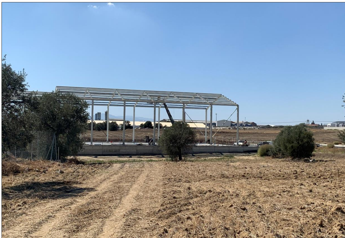
Φωτογραφία 12: Κατασκευαστικά έργα.
