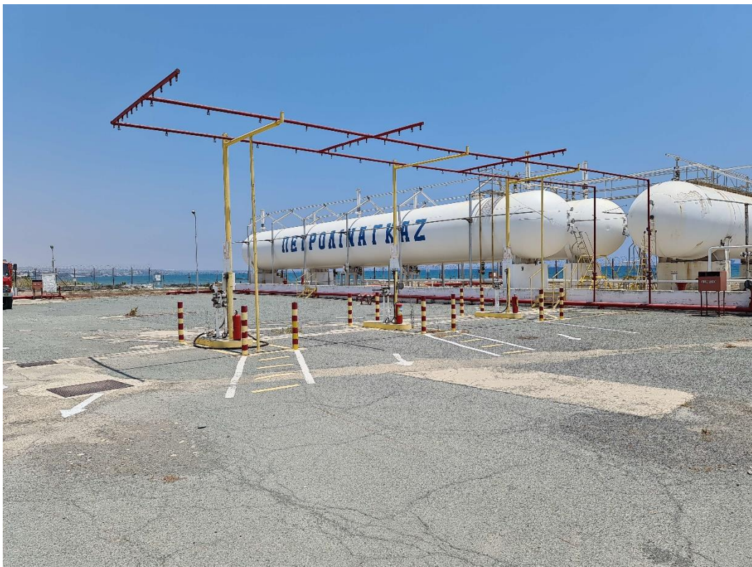
Εικόνα 3-5 Δεξαμενές αποθήκευσης υγραερίου (Αρ. 5 - 6 - 7 στην Εικόνα 3.3) και νησίδες φόρτωσης που θα αποξηλωθούν
