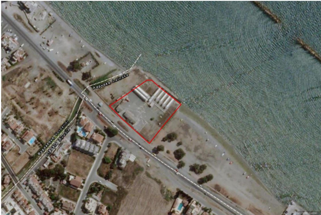
Εικόνα 1.6 : Δυτική όψη ΕΠΜ (ArcGIS Earth, 2021).
