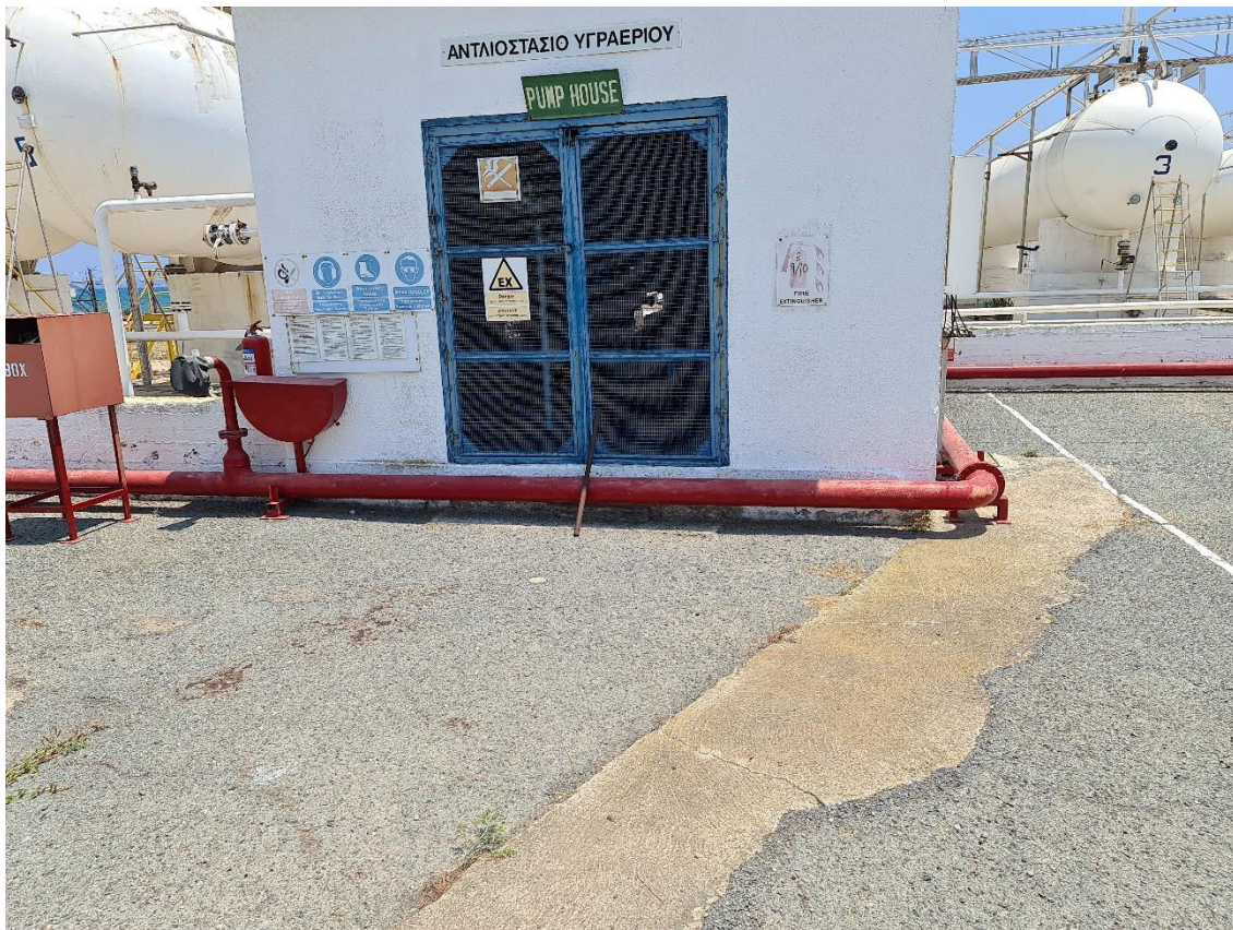
Εικόνα 3-10 Αντλιοστάσιο που θα αποξηλωθεί
