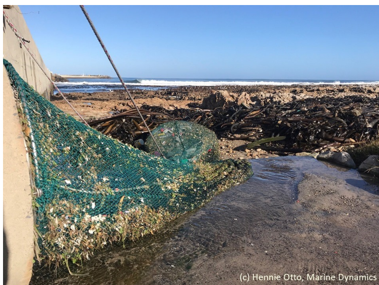
Φωτο 7.2 Σύστημα συλλογής απορριμμάτων στην έξοδο των δύο αγωγών ομβρίων
