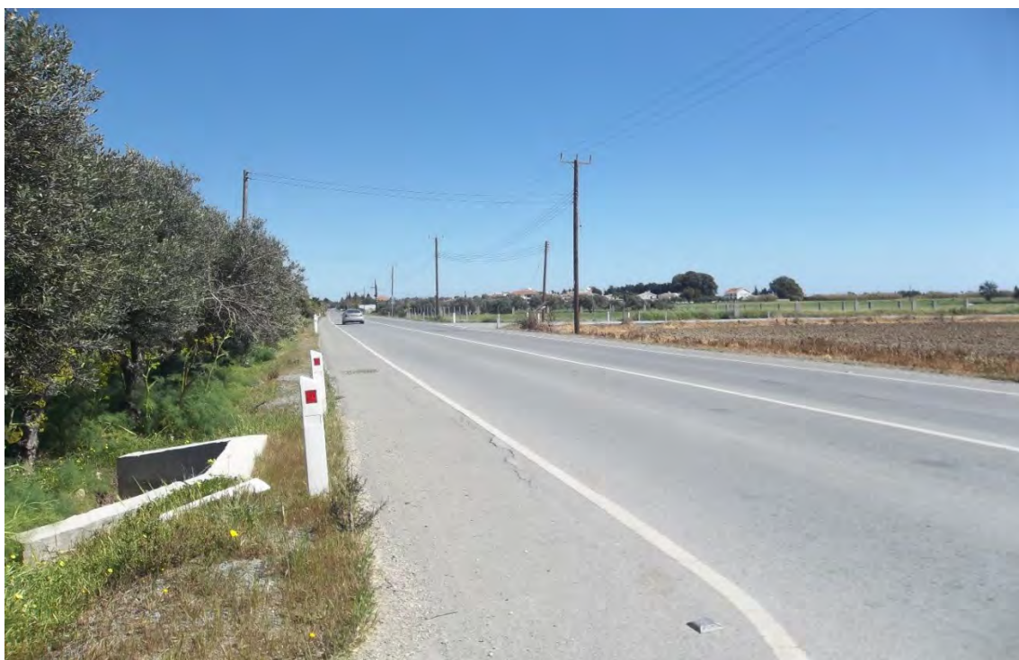
Εικόνα 3: Περιοχή εγκατάστασης αντλιοστασίου CF
