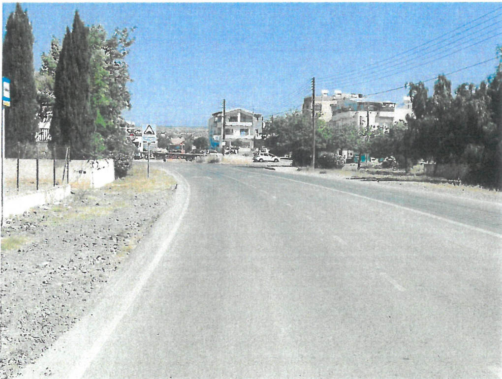
Φωτογραφία 6: Ευρύτερη Περιοχή Μελέτης (ΕΠΜ). Οδός Πετράκη Γιάλλουρου όπου και θα καταλήξει το δίκτυο συλλογής ομβρίων υδάτων
