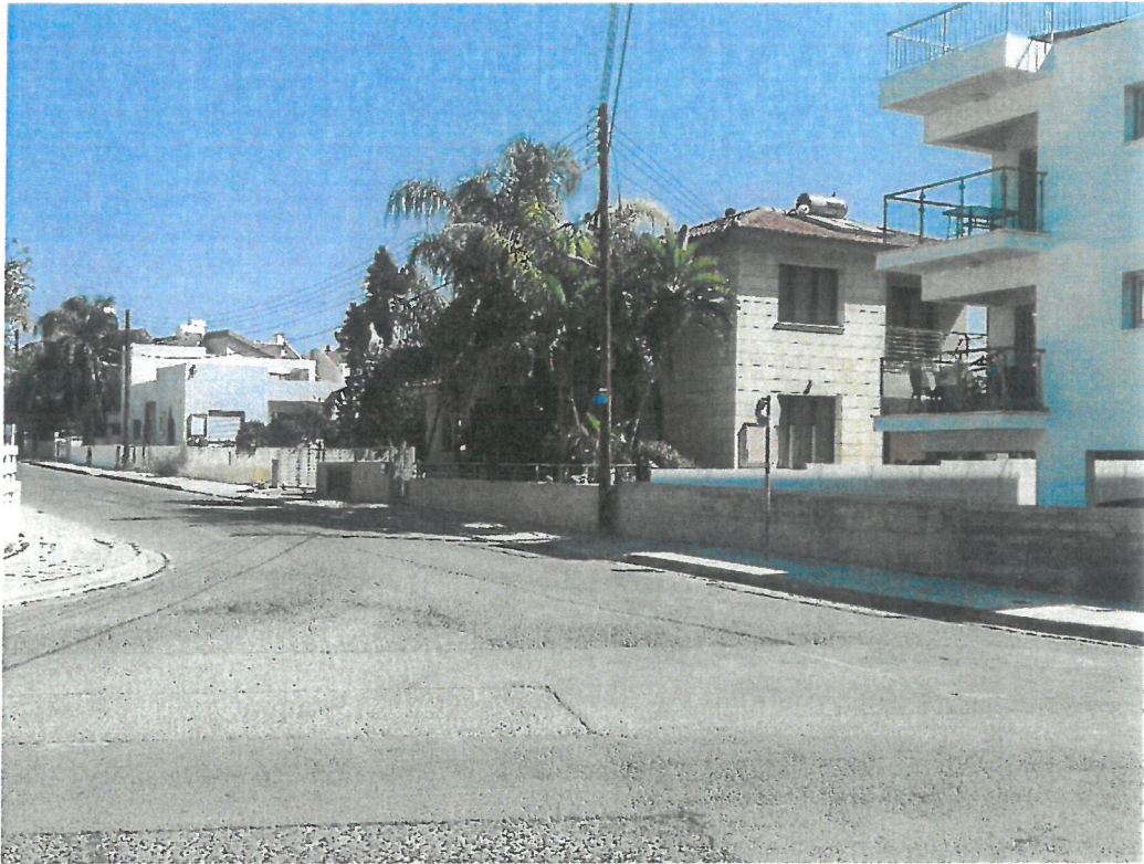
Φωτογραφία 5: Άμεση Περιοχή Μελέτης (ΑΠΜ). Σταυροδρόμι των οδών Ευρώπης & Τριών Ιεραρχών όπου και θα αφηθεί μελλοντική ένωση για την επέκταση του δικτύου συλλογής ομβρίων υδάτων επί της οδού Ευρώπης
