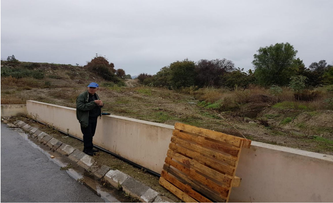
Φωτογραφία 3: Τοίχος αντιστήριξης στο ΒΑ άκρο του εμπορικού κέντρου
