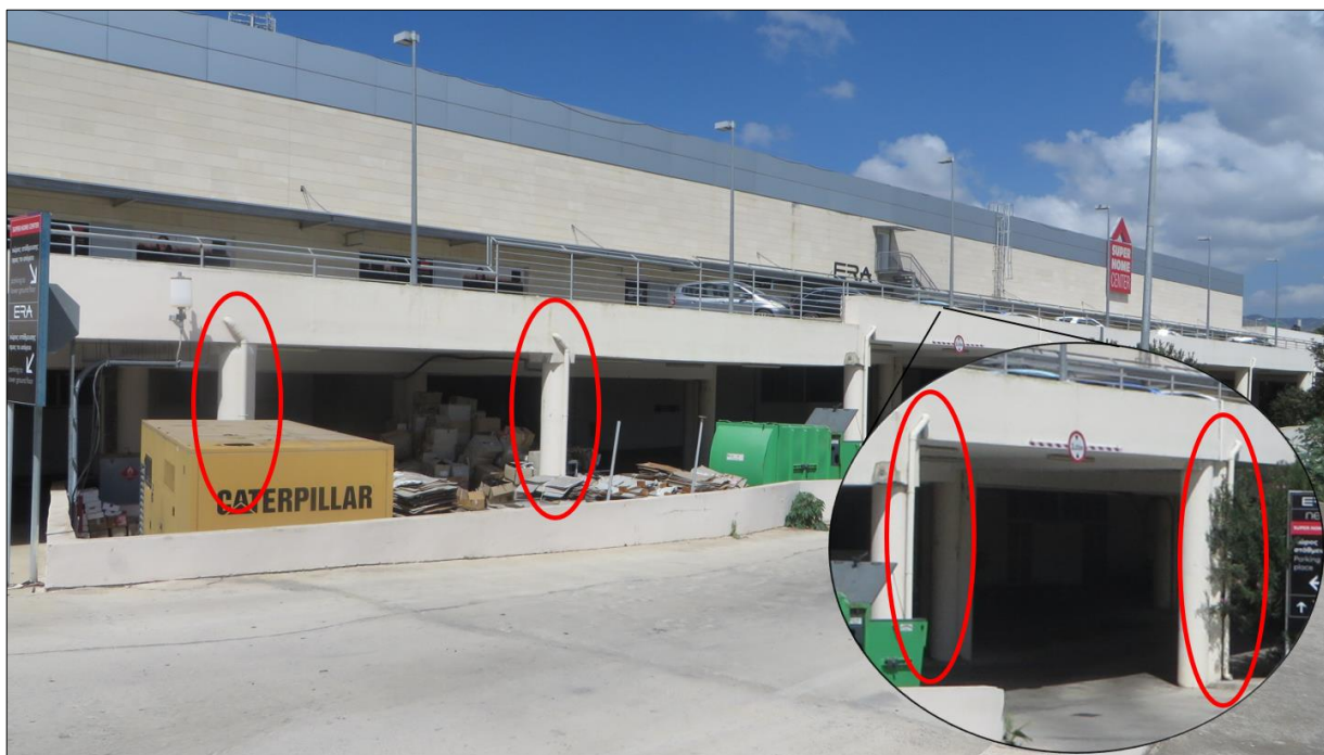
Φωτογραφία 14: Μέρος του συστήματος διαχείρισης όμβριων υδάτων (ανατολική πλευρά)
