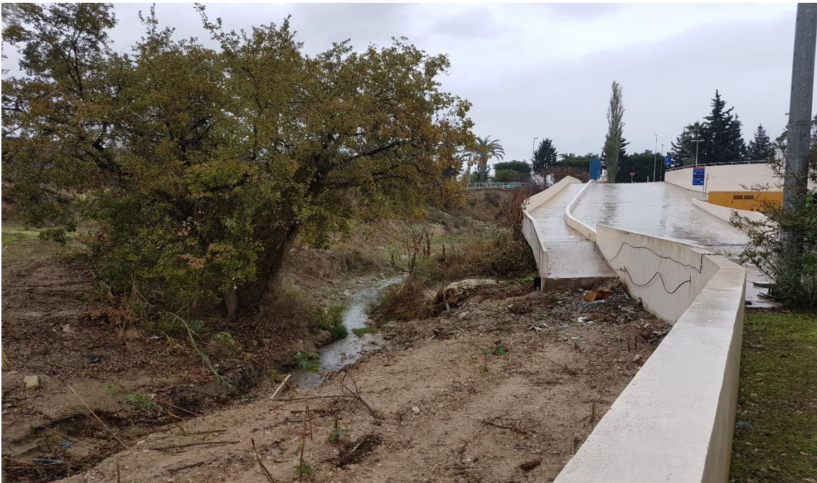
Φωτογραφία 2: Ενεργός κοίτη ρυακίου – προς κατάντη
