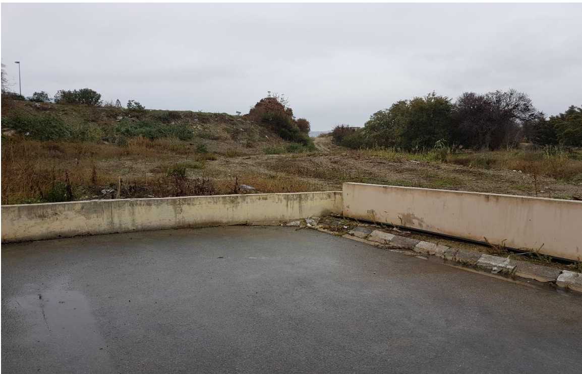
Φωτογραφία 4: Τοίχος αντιστήριξης στο ΒΑ άκρο του εμπορικού κέντρου - χώρος προς επίχωση (πάχος 30-50 εκ.), εκτός του δομημένου χώρου.
