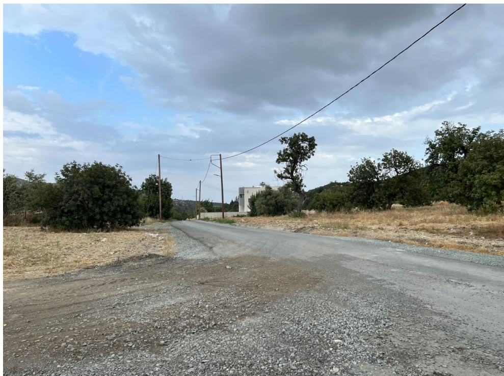
ΠΕΡΙΟΧΗ ΤΟΠΙΚΟΥ ΑΝΤΛΙΟΣΤΑΣΙΟΥ ΛΥΜΑΤΩΝ PSP2
