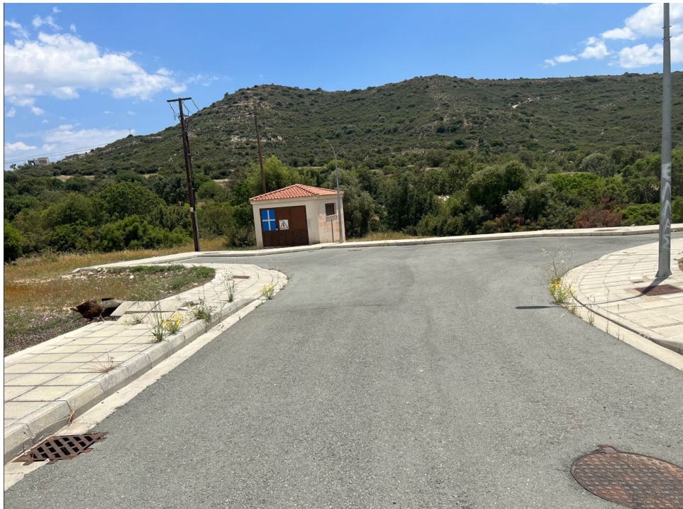
ΠΕΡΙΟΧΗ ΤΟΠΙΚΟΥ ΑΝΤΛΙΟΣΤΑΣΙΟΥ ΛΥΜΑΤΩΝ PSP1
