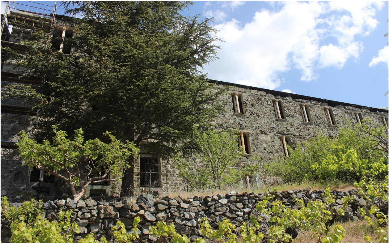
Φωτογραφία 2.1: Το υφιστάμενο κτήριο του Ξενοδοχείου Βερεγγάρια (όψη από τα βόρεια προς τα νότια).
