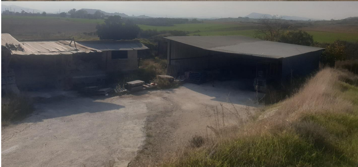
Φωτογραφίες 7, 8, 9: Μονάδα επεξεργασίας και αποθήκευσης αδρανών στην άμεση περιοχή του έργου
