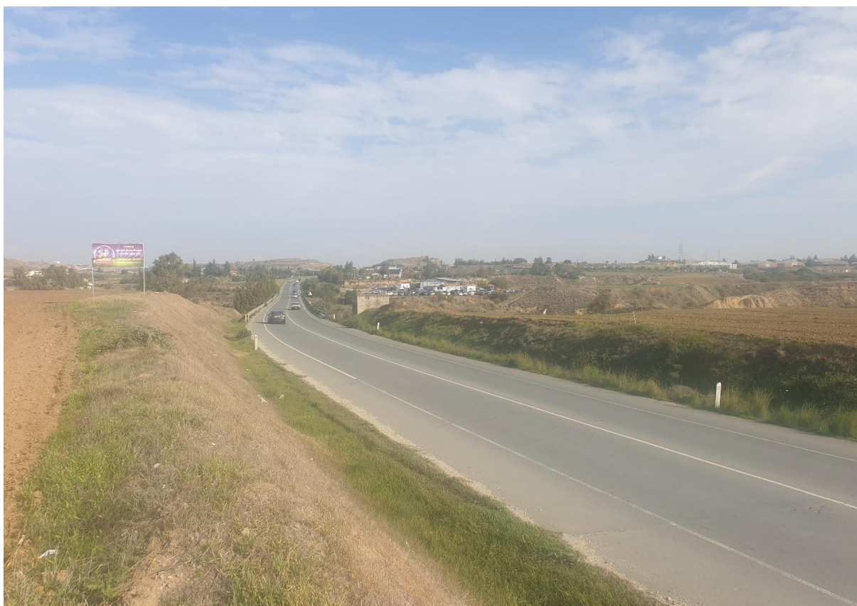
Φωτογραφία 13: Οδικό δίκτυο E903 στην άμεση περιοχή του έργου
