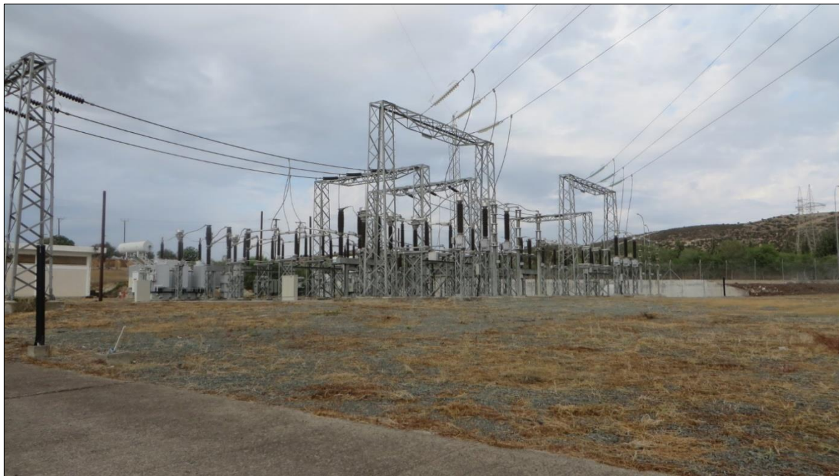
Φωτογραφία 1: Το τεμάχιο όπου θα χωροθετηθεί το προτεινόμενο Έργο. Η φωτογραφία τραβήχτηκε εντός του τεμαχίου.
