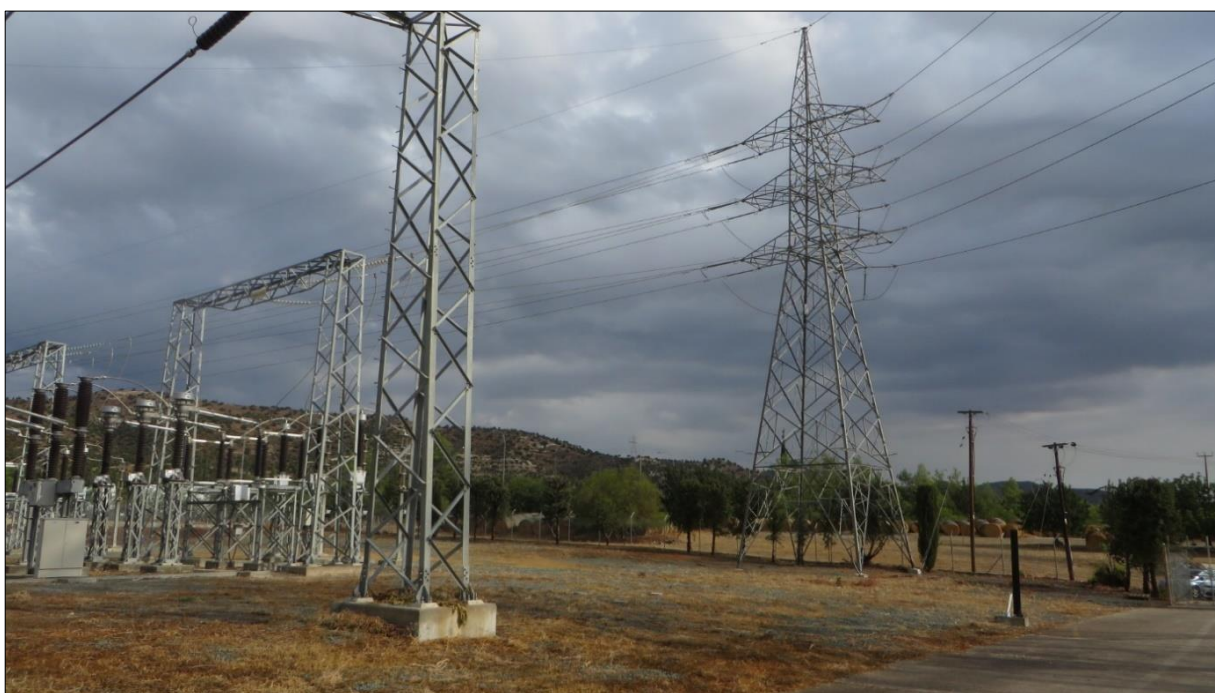
Φωτογραφία 6: Υφιστάμενες εγκαταστάσεις εντός του υπό μελέτη τεμαχίου.
