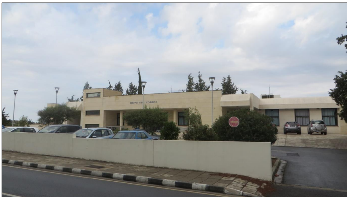
Φωτογραφία 21: Κέντρο υγείας Κοφίνου
