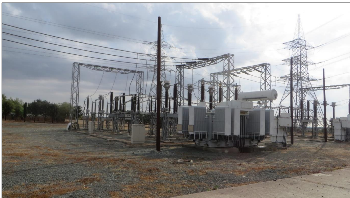
Φωτογραφία 7: Υφιστάμενες εγκαταστάσεις εντός του υπό μελέτη τεμαχίου.
