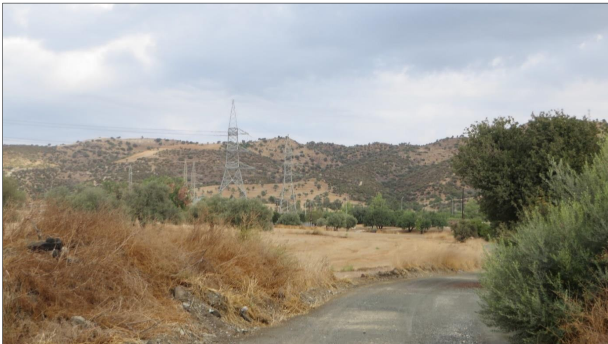
Φωτογραφία 13: Πρόσβαση προς το υπό μελέτη τεμάχιο. Στο φόντο διακρίνονται οι υφιστάμενες εγκαταστάσεις του υποσταθμού.
