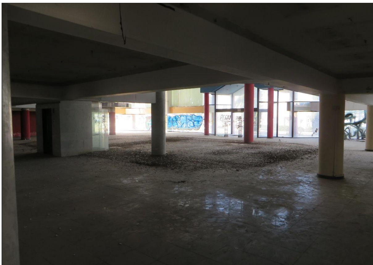
Φωτογραφία 13: Εντός του υφιστάμενου κτιρίου, που στο παρόν στάδιο δεν χρησιμοποιείται.
