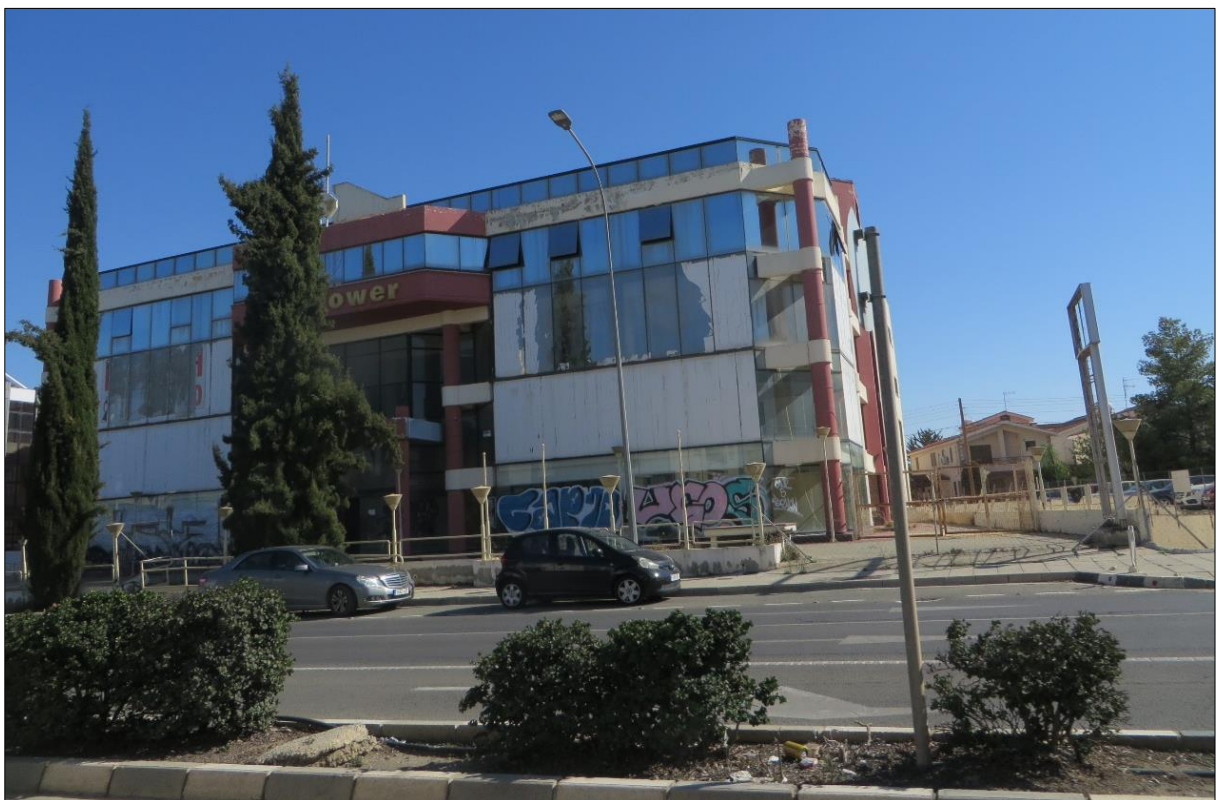
Φωτογραφία 7: Το υφιστάμενο κτίριο που θα τροποποιηθεί. Η φωτογραφία τραβήχτηκε από τη Λεωφόρο Στροβόλου.
