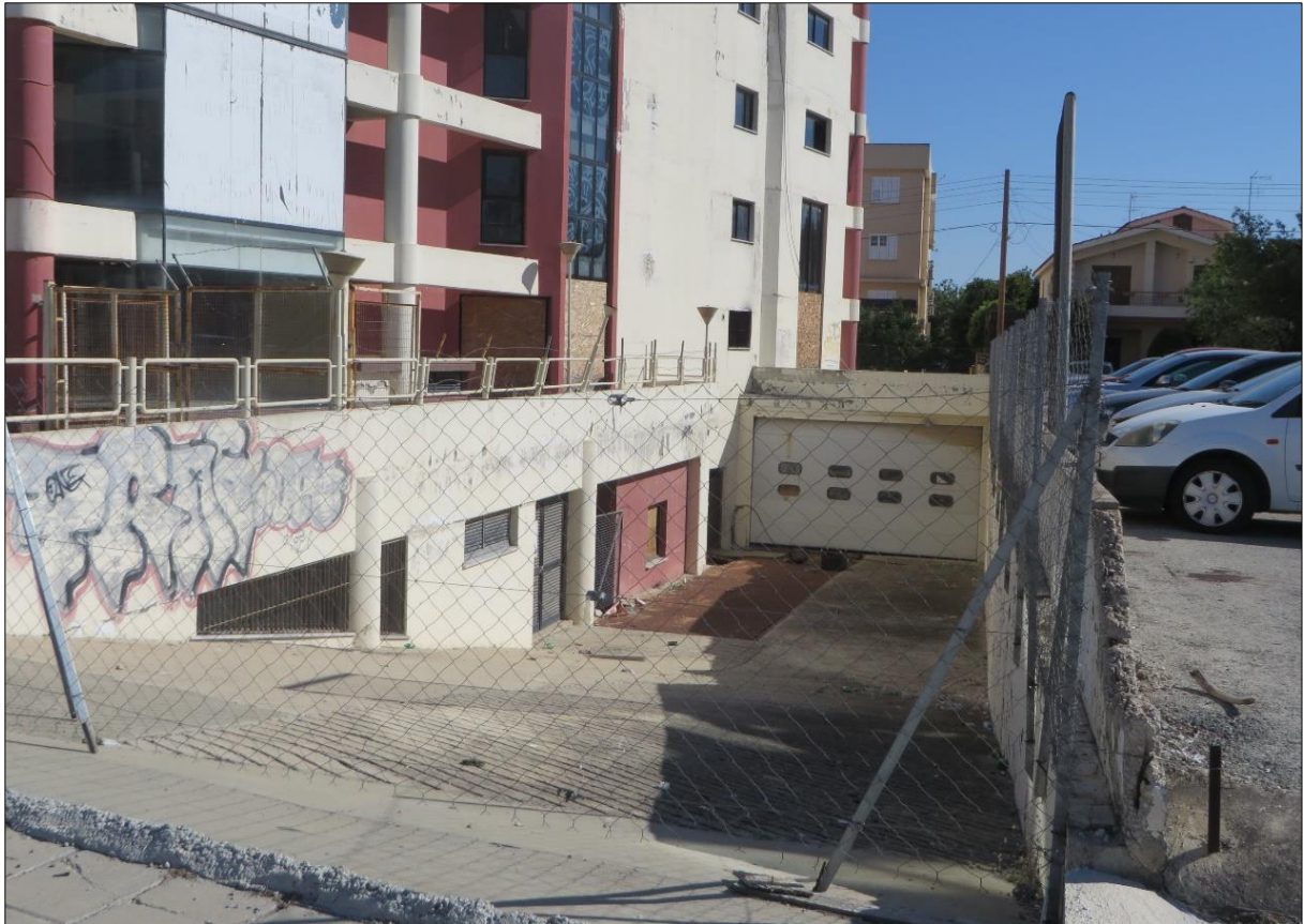
Φωτογραφία 8: Περιφραγμένη πρόσβαση στο υπόγειο του υφιστάμενου κτιρίου, εντός του χώρου ανάπτυξης, από τη Λεωφόρο Στροβόλου.
