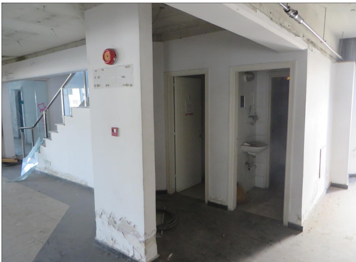
Φωτογραφία 14: Εντός του υφιστάμενου κτιρίου, που στο παρόν στάδιο δεν χρησιμοποιείται.
