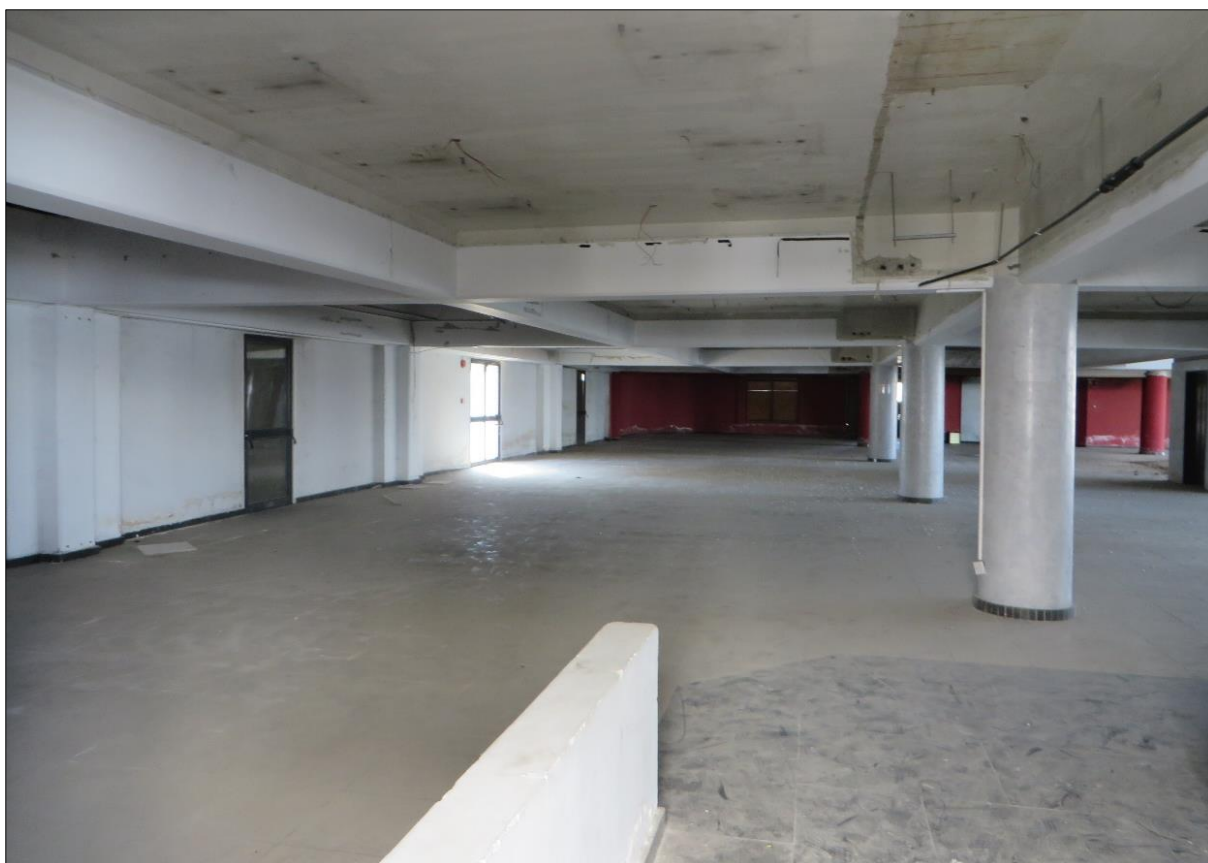
Φωτογραφία 12: Εντός του υφιστάμενου κτιρίου, που στο παρόν στάδιο δεν χρησιμοποιείται.
