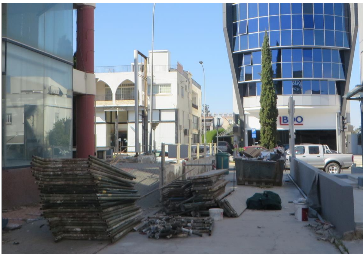
Φωτογραφία 11: Σκαλωσιές και σκιπ (skip), στο βόρειο – βορειοανατολικό άκρο του χώρου ανάπτυξης.
