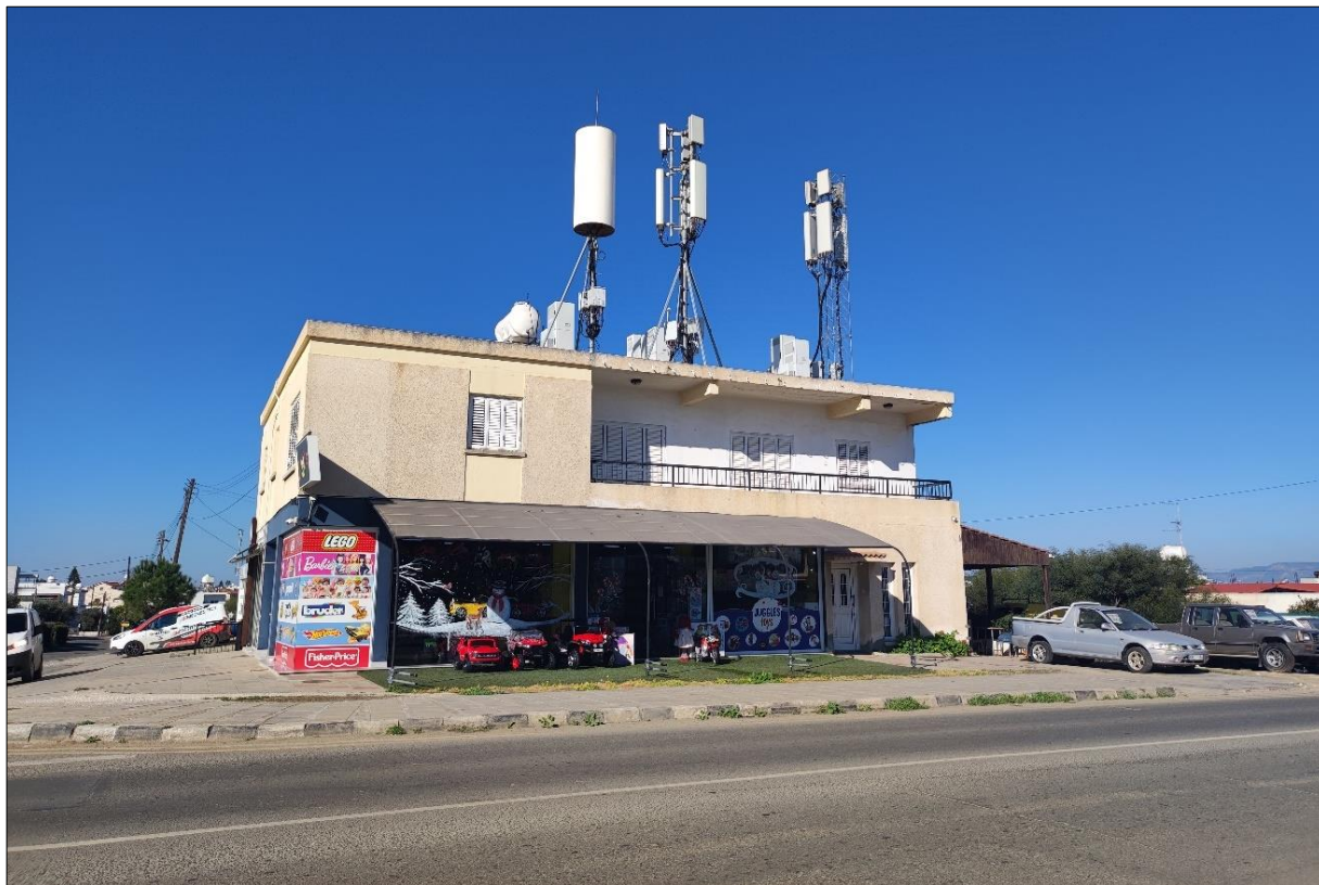
Φωτογραφία 5: Μικτή χρήση που εντοπίζεται δυτικά του χώρου ανάπτυξης του προτεινόμενου Έργου.
