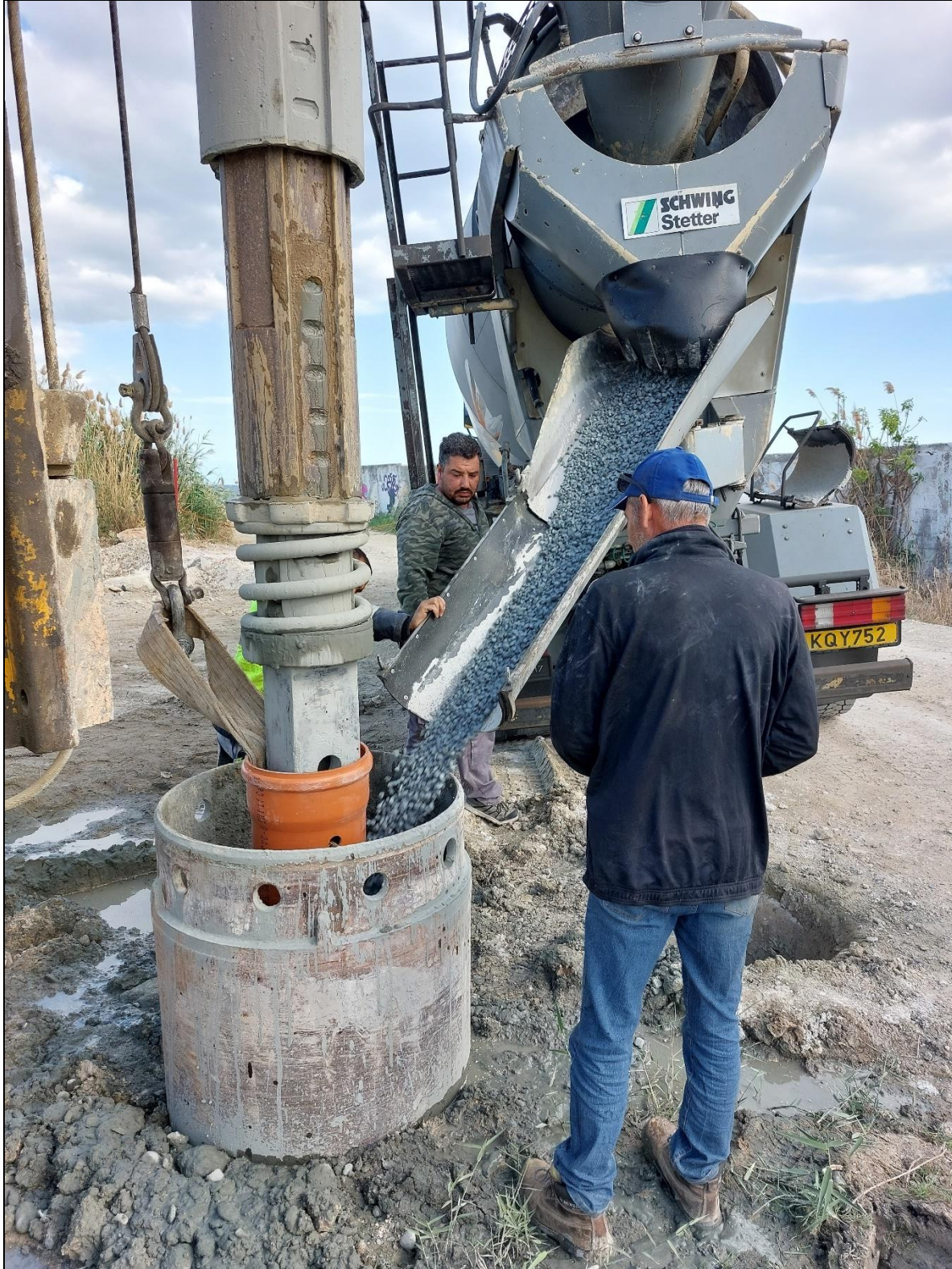
ΤΟΠΟΘΕΤΗΣΗ ΔΙΑΤΡΗΤΗΣ ΘΩΡΑΚΙΣΗΣ ΚΑΙ ΧΑΛΙΚΟΦΙΛΤΡΟΥ
