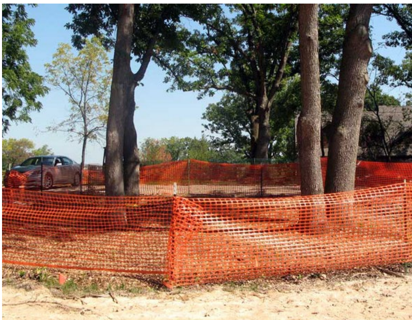
Εικόνα 16: Παράδειγμα τοποθέτησης περίφραξης για την προστασία των δέντρων
