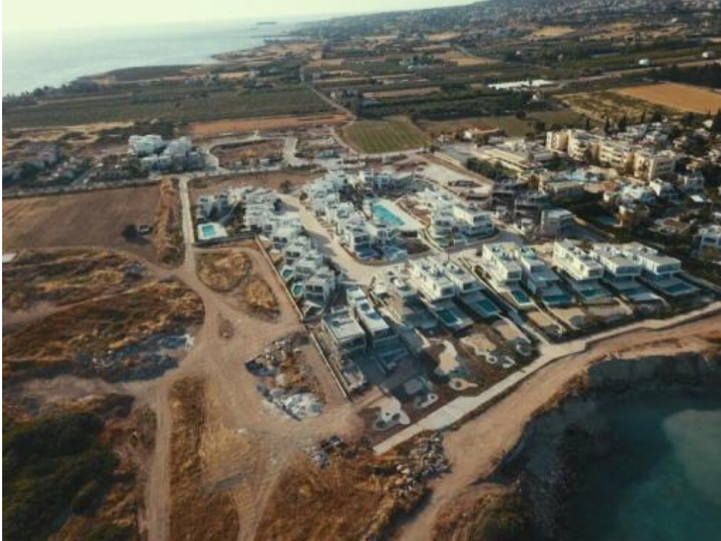
Φωτογραφία 1: Τεμάχιο ανέγερσης του ΠΕ – από ανατολική προς δυτική όψη
