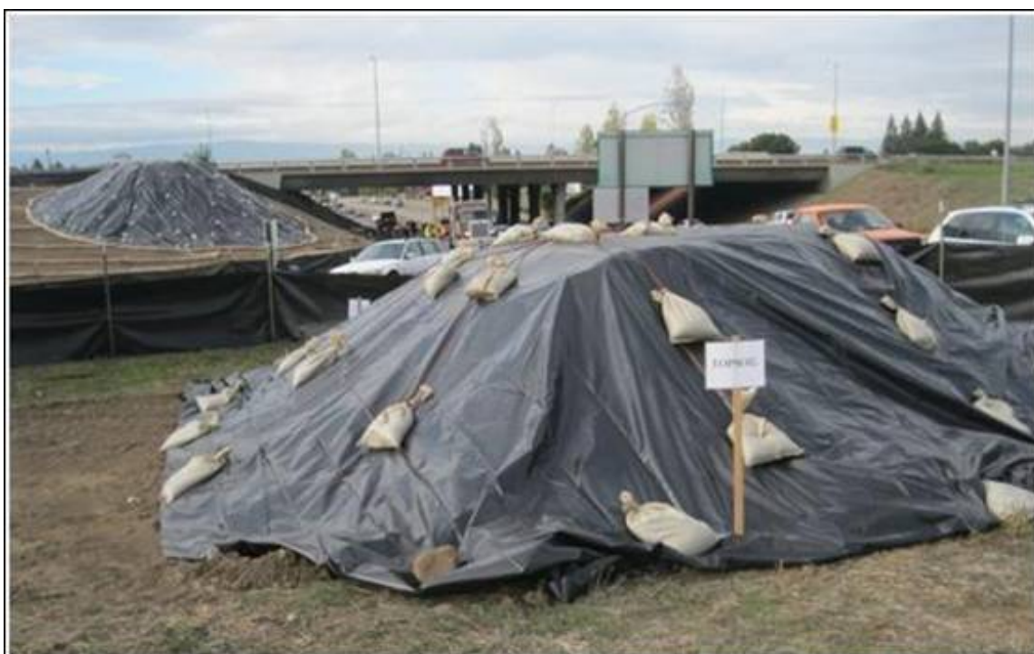
Εικόνα 6: Πλαστική Μονωτική Μεμβράνη κάλυψης αδρανών υλικών/μπαζών εργοταξίου
