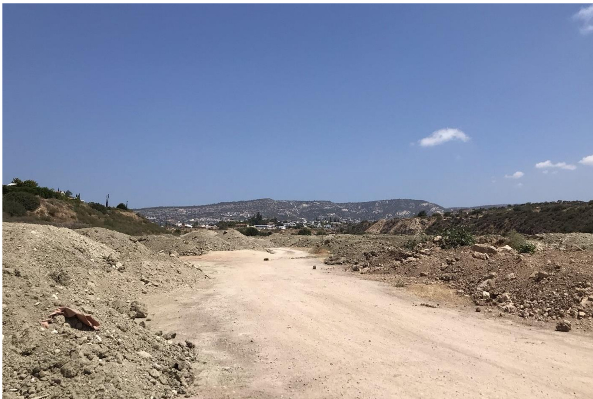
Φωτογραφία 19: Σωροί από μπάζα που εντοπίστηκαν ανατολικά του χώρου ανάπτυξης.
