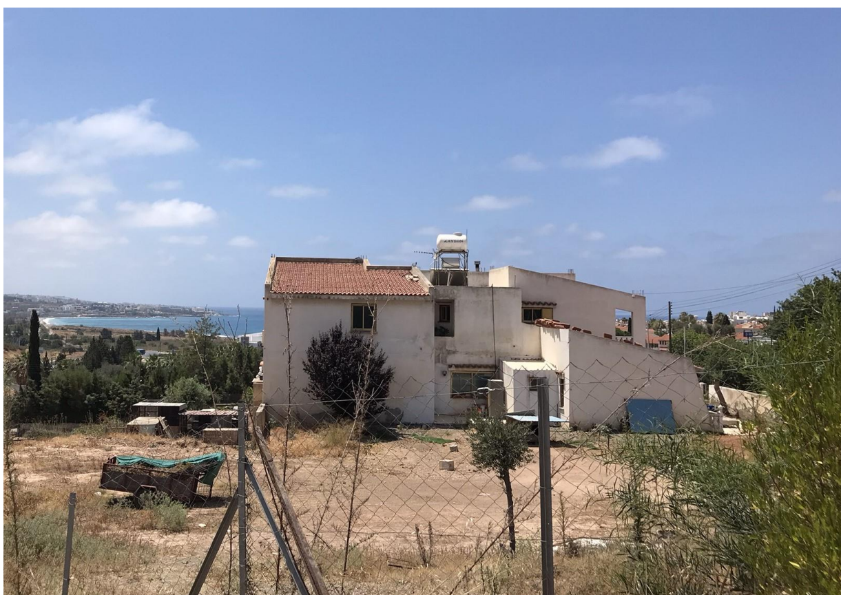
Φωτογραφία 12: Οικιστική ανάπτυξη που εφάπτεται με το χώρο ανάπτυξης στο νότιο σύνορο.
