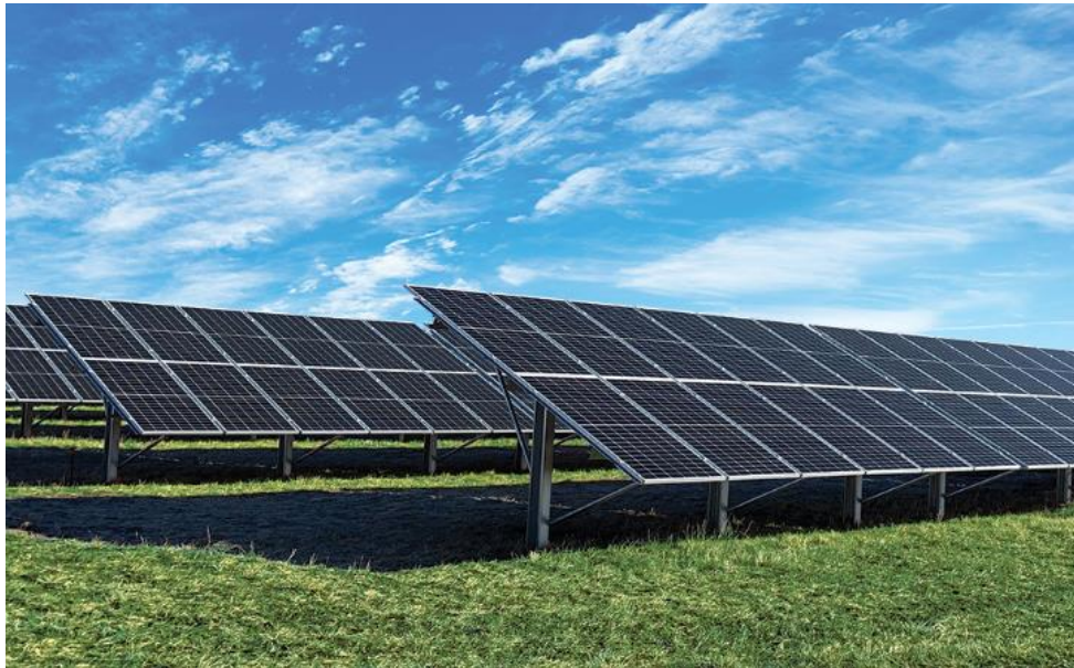
Εικόνα 13: Τυπική διάταξη και έδραση των πλαισίων και των σταθερών βάσεων στήριξης
