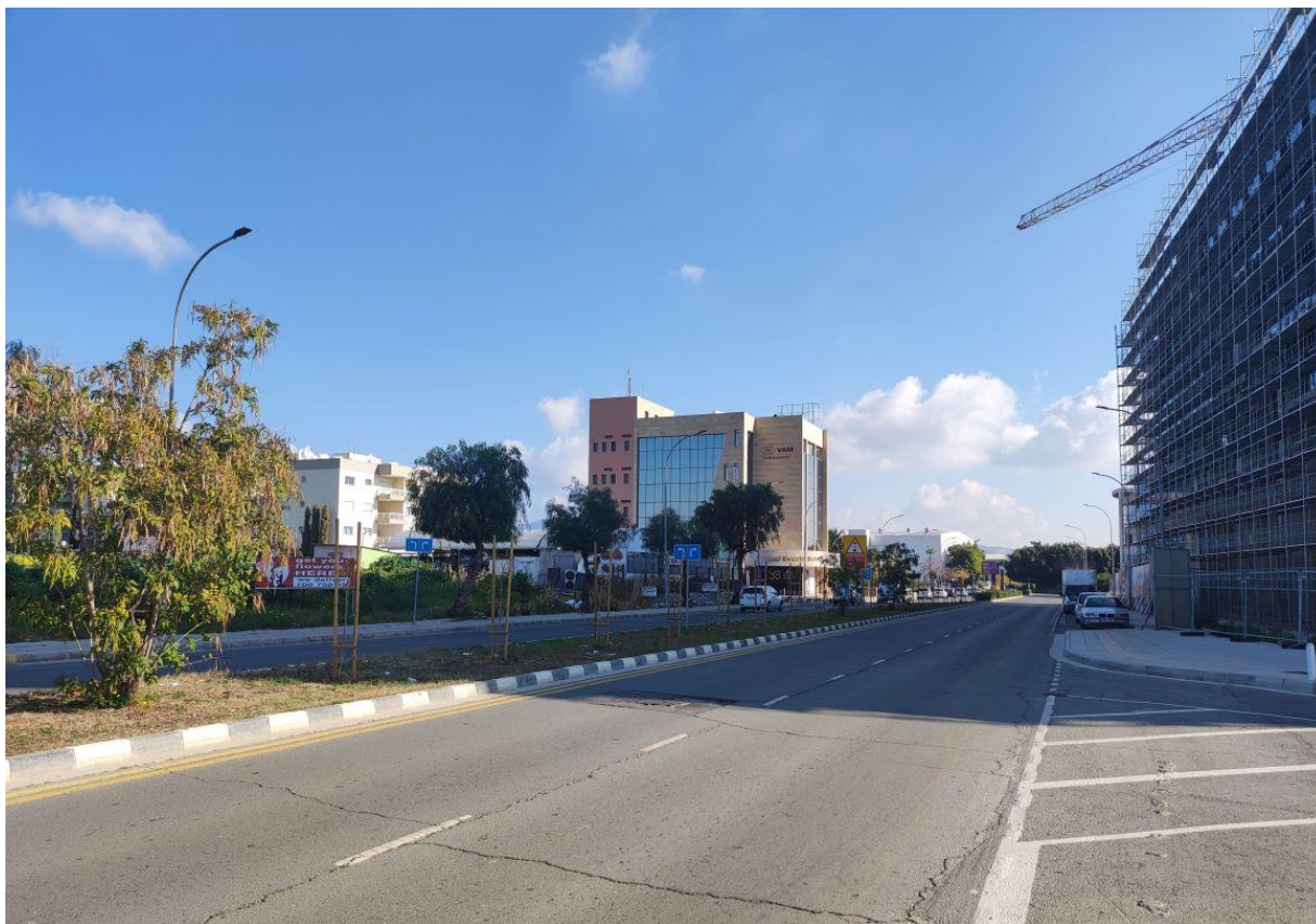
Φωτογραφία 9: Μεικτές αναπτύξεις και υπό κατασκευή έργο επί της Λεωφόρου Σπύρου Κυπριανού που βρίσκεται βόρεια του υπό μελέτη τεμαχίου.
