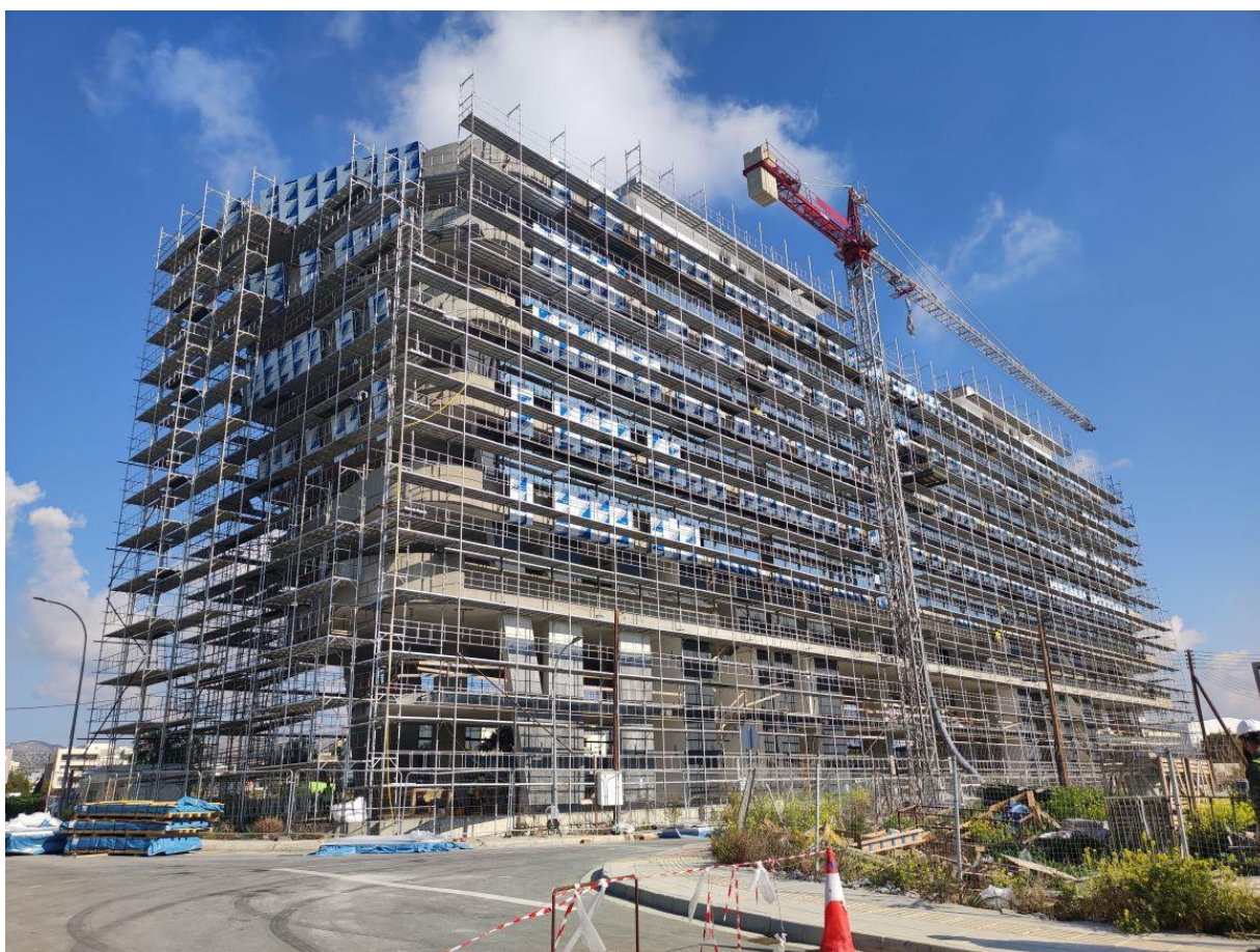
Φωτογραφία 8: Υπό κατασκευή έργο που εντοπίζεται ανατολικά του υπό μελέτη τεμαχίου.
