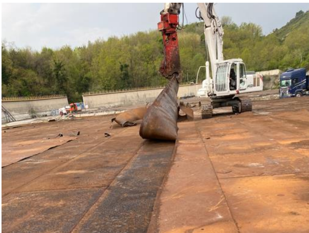
Εικόνα 6 - Φωτογραφική απεικόνιση αφαίρεσης των μεταλλικών πλακών του πυθμένα
