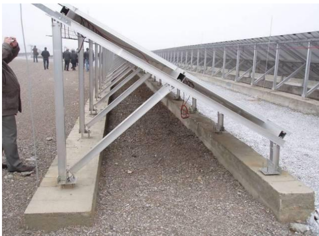
Φωτογραφία 18. Θεμελίωση Φωτοβολταϊκού Πάρκου.
