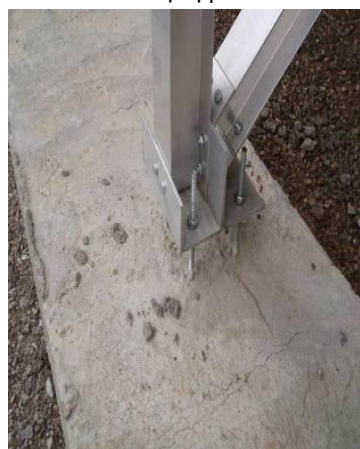
Φωτογραφία 17. Πέδιλο από σκυρόδεμα και τοποθέτηση βάσεων.
