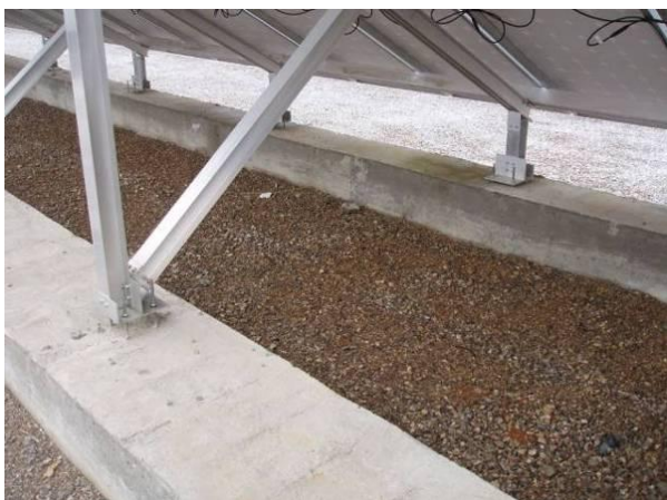
Φωτογραφία 16. Θεμελίωση Φωτοβολταϊκού Πάρκου.
