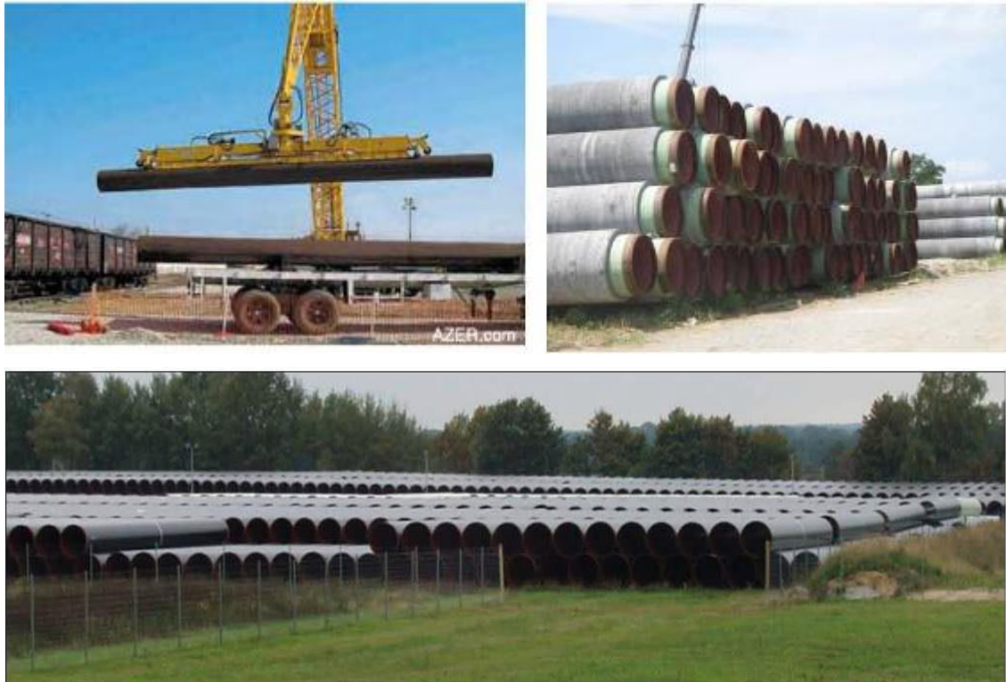
Σχήμα 3.2 Εκφόρτωση και στοίβαξη σωληνωαγωγών
